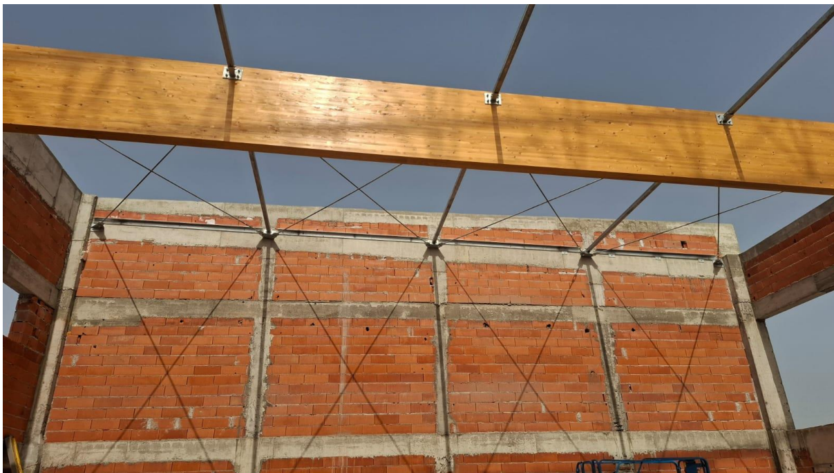
Slika 33. - Postavljeni LLD nosači
