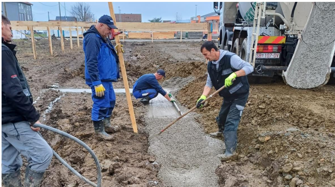
Slika 17. - Betoniranje temeljnih traka
