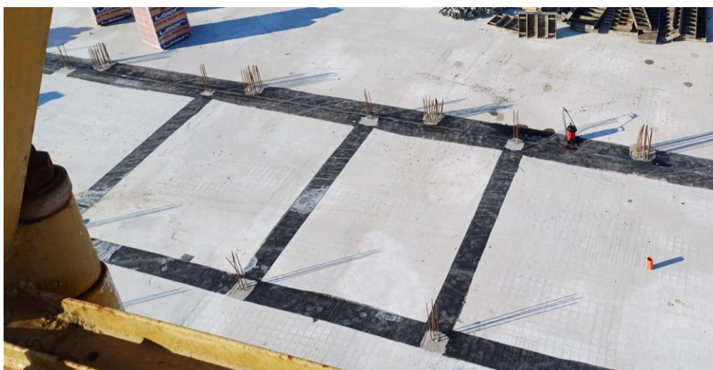
Slika 42. - Hidroizolacija kod betonskih nastavka
