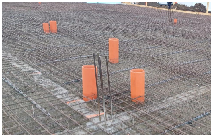
Slika 23. - Proturane cijevi
