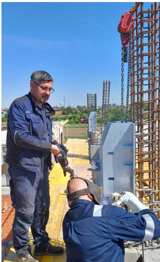
Slika 31. - Postavljanje čeličnih ležajeva za LLD nosače
