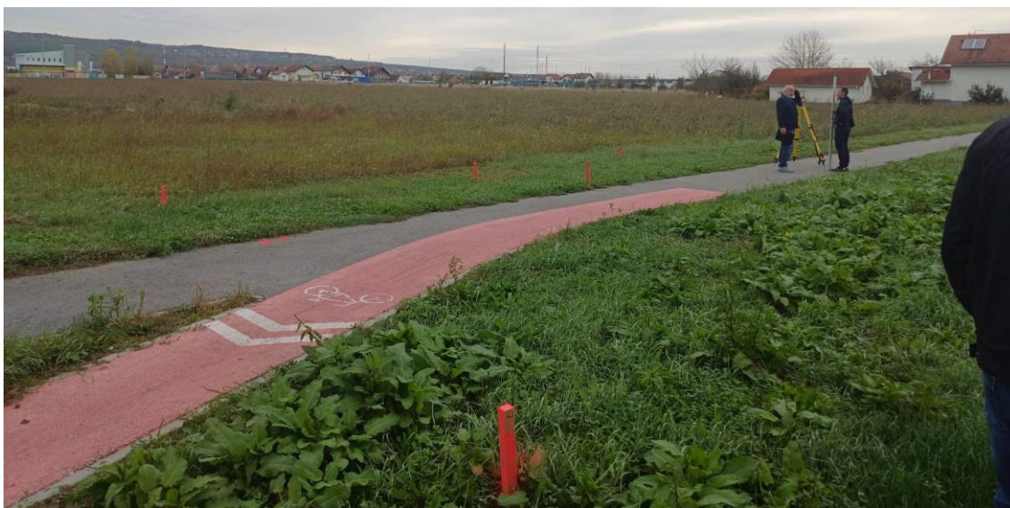
Slika 6. - Iskolčenje zgrade
