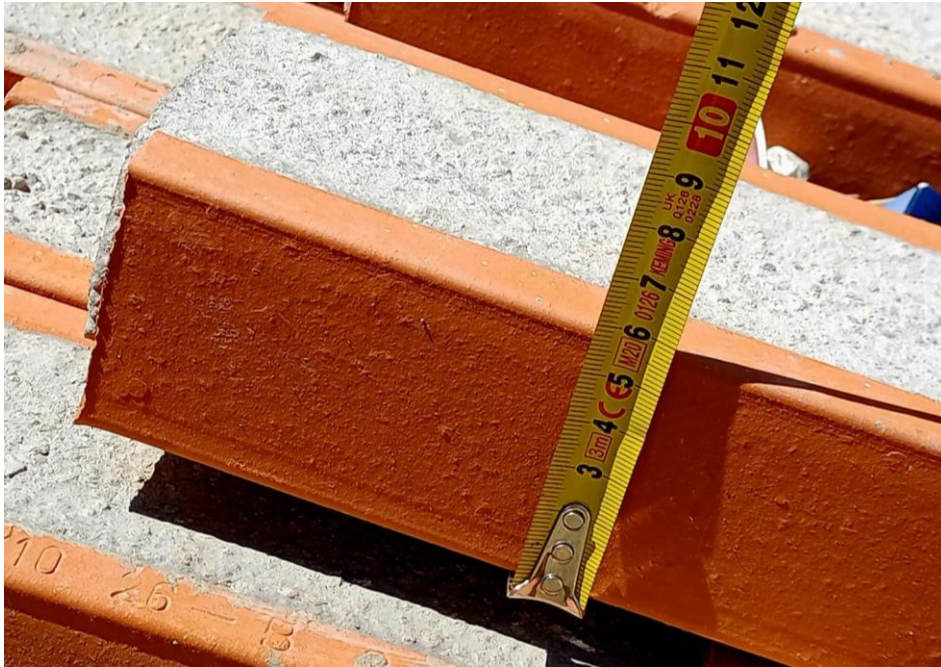
Slika 30. - AB montažni nadvoj
