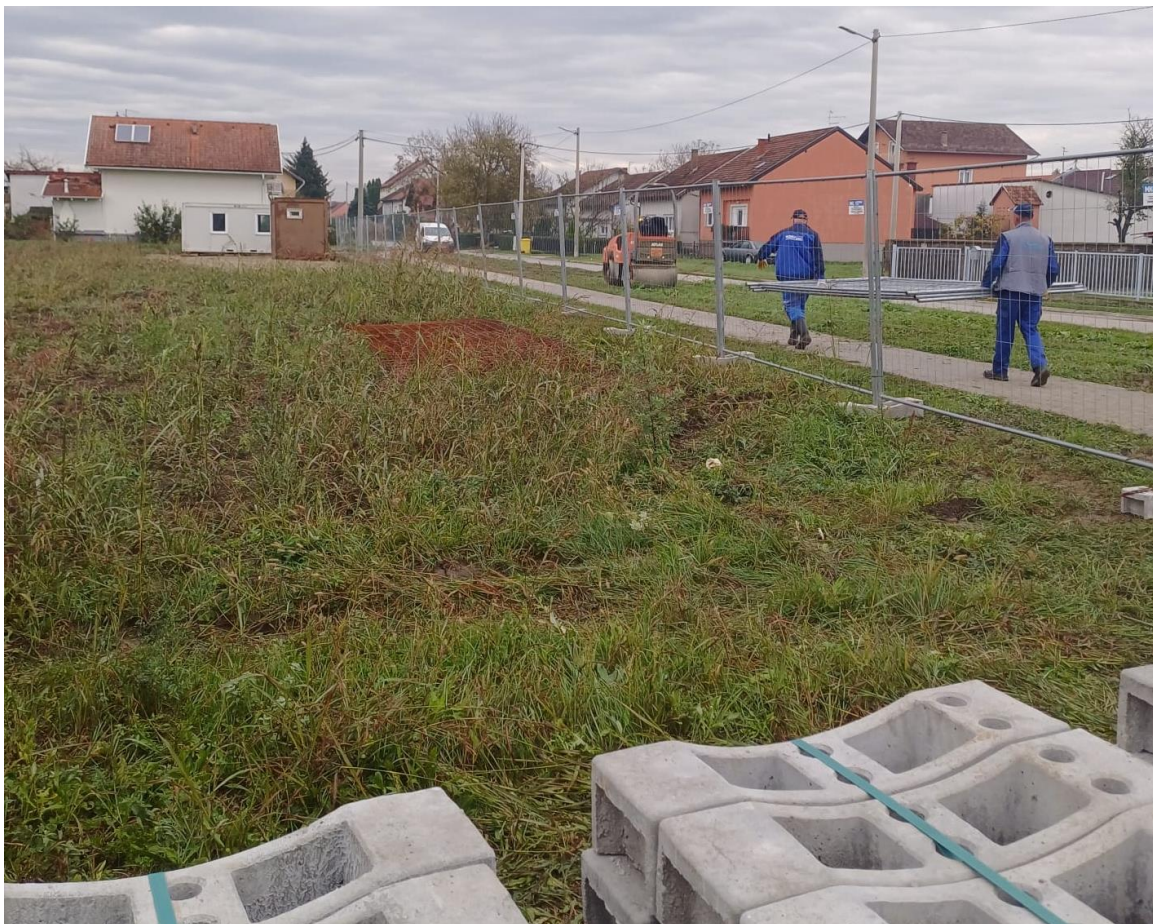
Slika 9. - Postavljanje gradilišne ograde
