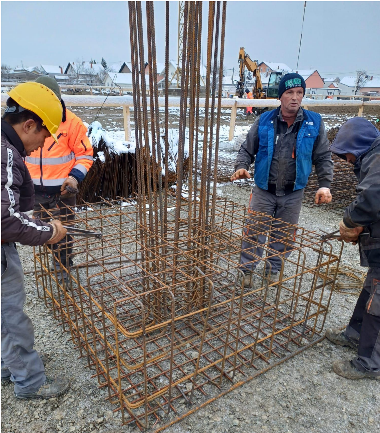
Slika 24. - Vezivanje armature temeljne stope
