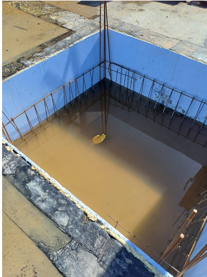
Slika 43. - Hidroizolacija jame okna dizala
