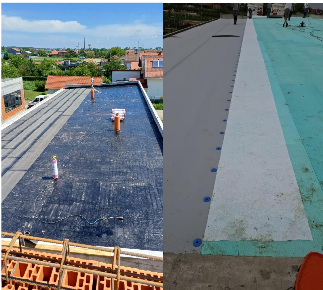
Slika 44. i 45. – slojevi neprohodnog krova
