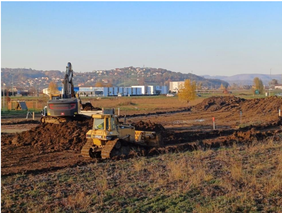
Slika 12. - Skidanje humusa i široki strojni iskop sa bagerom i buldozerom
