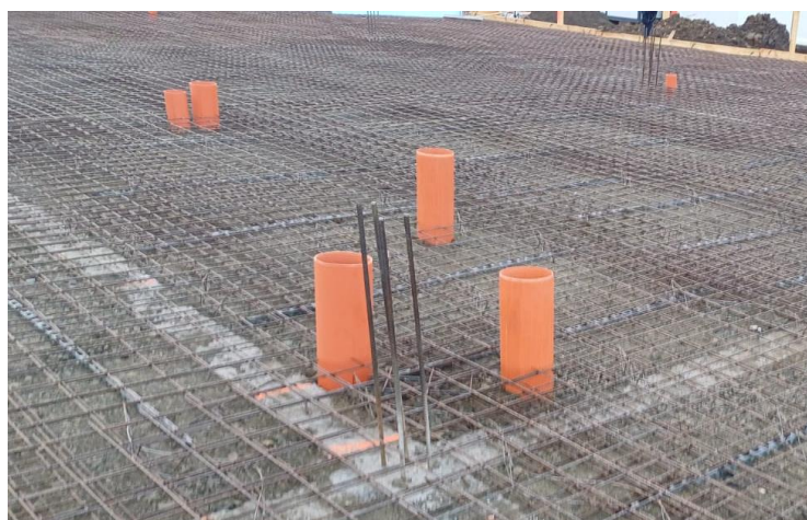
Slika 23. - Proturane cijevi
