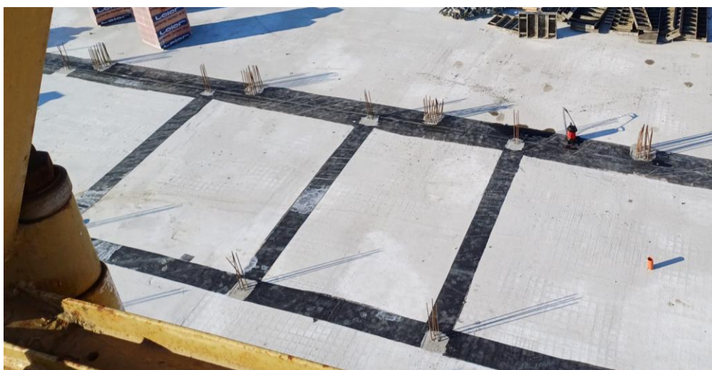
Slika 42. - Hidroizolacija kod betonskih nastavka
