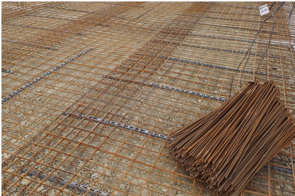
Slika 25. - Postavljanje mreža podne ploče preklop 3 okna
