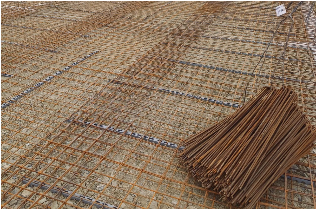
Slika 25. - Postavljanje mreža podne ploče preklop 3 okna
