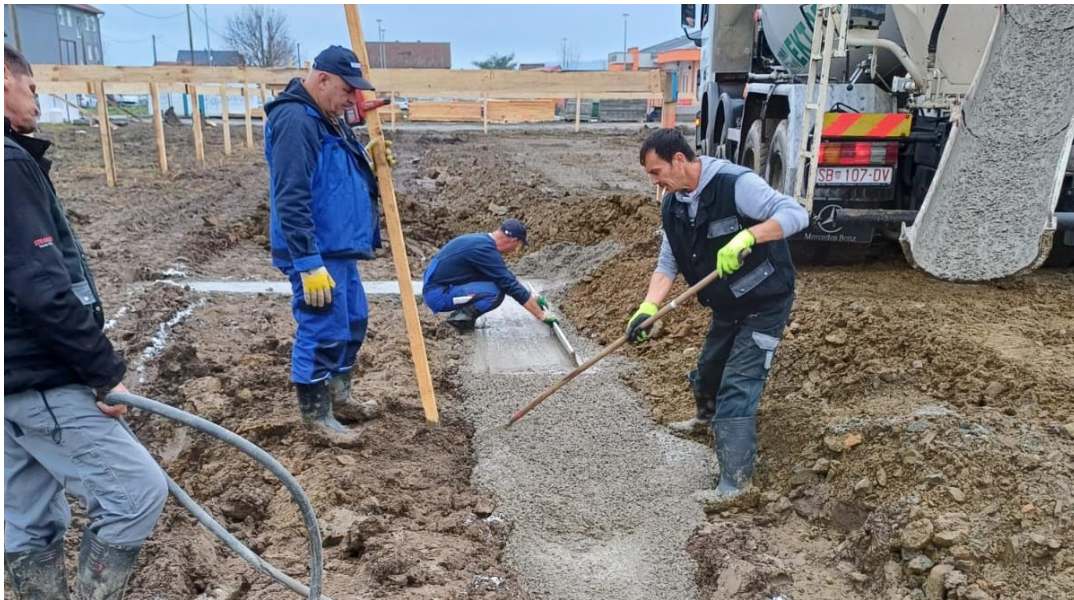
Slika 17. - Betoniranje temeljnih traka
