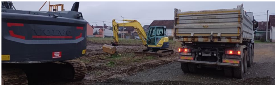
Slika 16. - Odvoz viška zemljanog materijala
