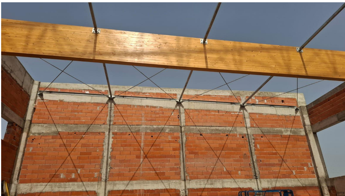
Slika 33. - Postavljeni LLD nosači
