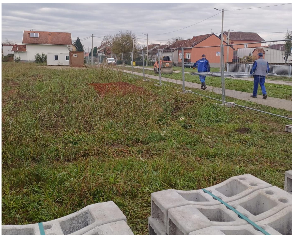
Slika 9. - Postavljanje gradilišne ograde
