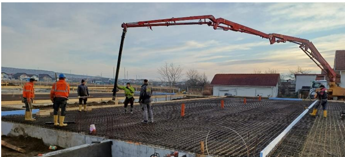
Slika 20. - Betoniranje podne ploče
