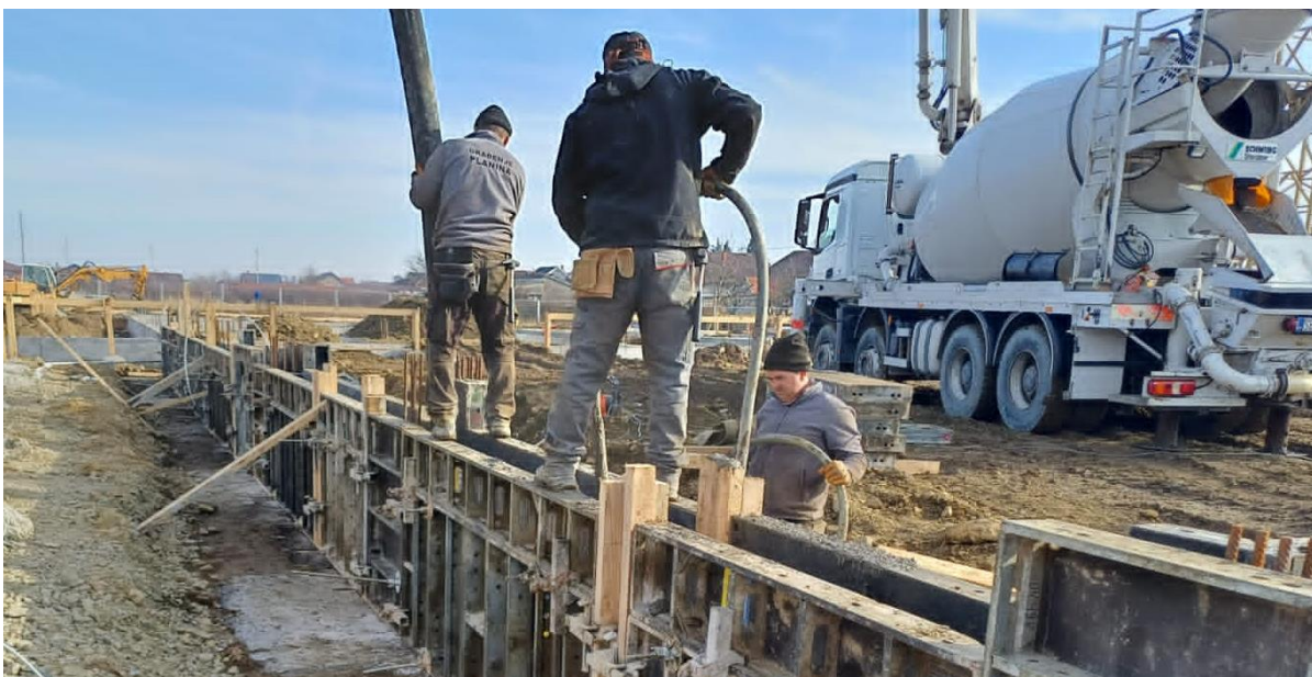
Slika 18. - Betoniranje AB nadtemeljnih greda
