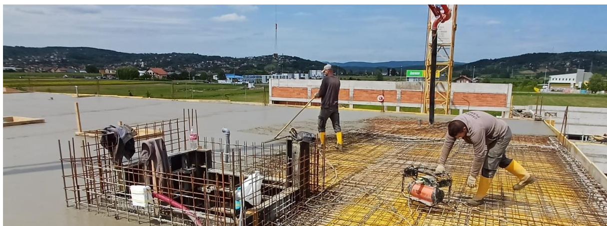
Slika 21. - Betoniranje stropne ploče u velikoplošnoj oplati
