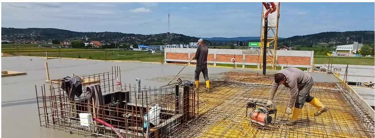
Slika 21. - Betoniranje stropne ploče u velikoplošnoj oplati
