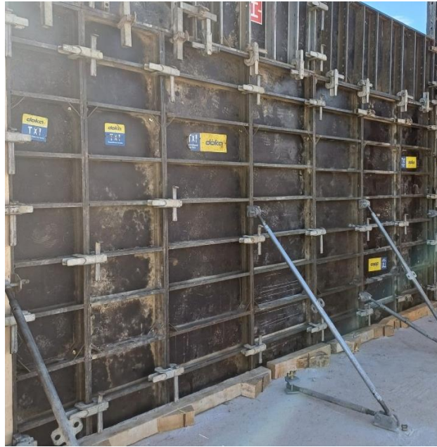
Slika 36. – Oplata AB zida
