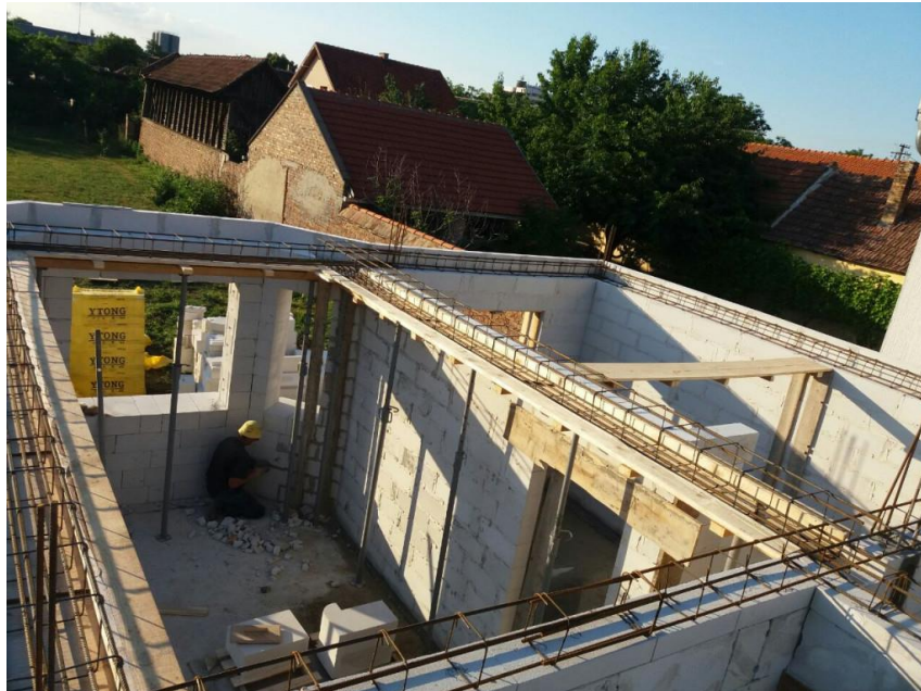
Slika 3.2.2 Prikaz primjera pripreme za betoniranje horizontalnih serklaža
