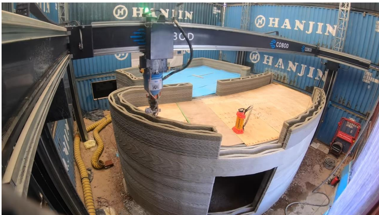
Slika 16: Izrada dvokatnice 3D ispisom
