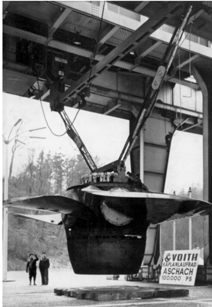
Slika 9. Kaplan turbina [13]
