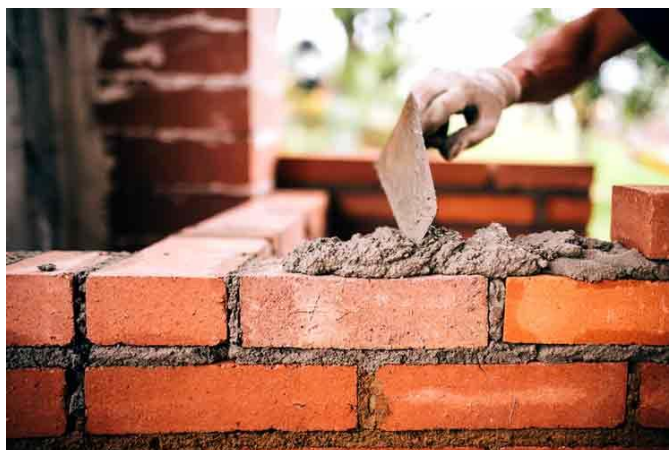
Slika 3.1 Zidanje mortom na bazi cementa [8]
