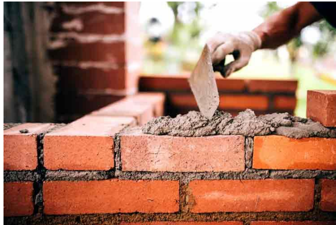
Slika 3.1 Zidanje mortom na bazi cementa [8]
