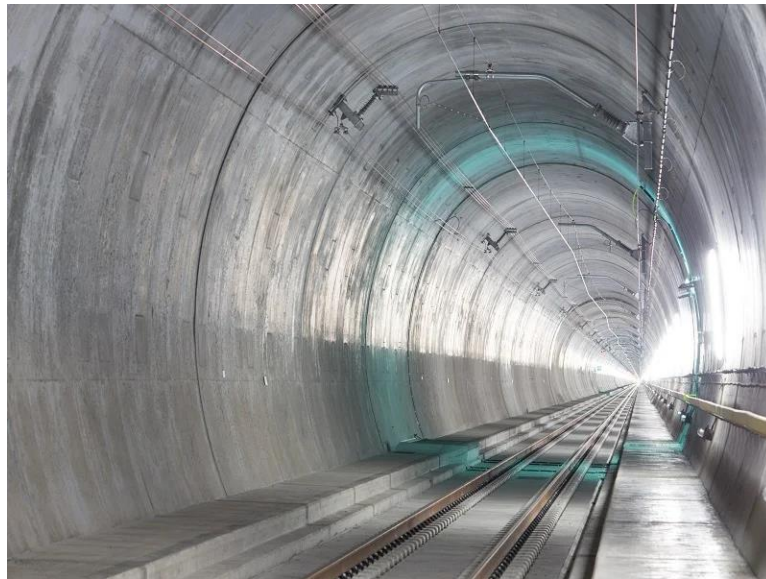
Slika 2. Tunel St. Gothard u Švicarskoj
