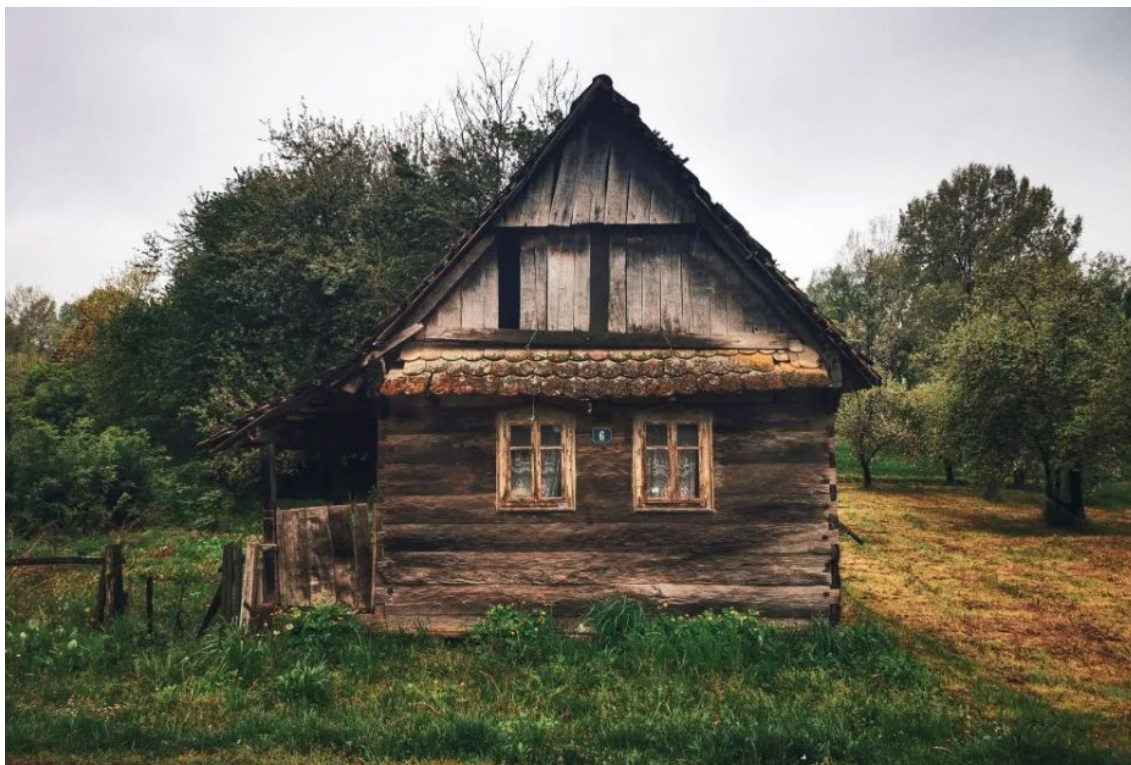
Slika 5 – Stara drvena turopoljska kuća
