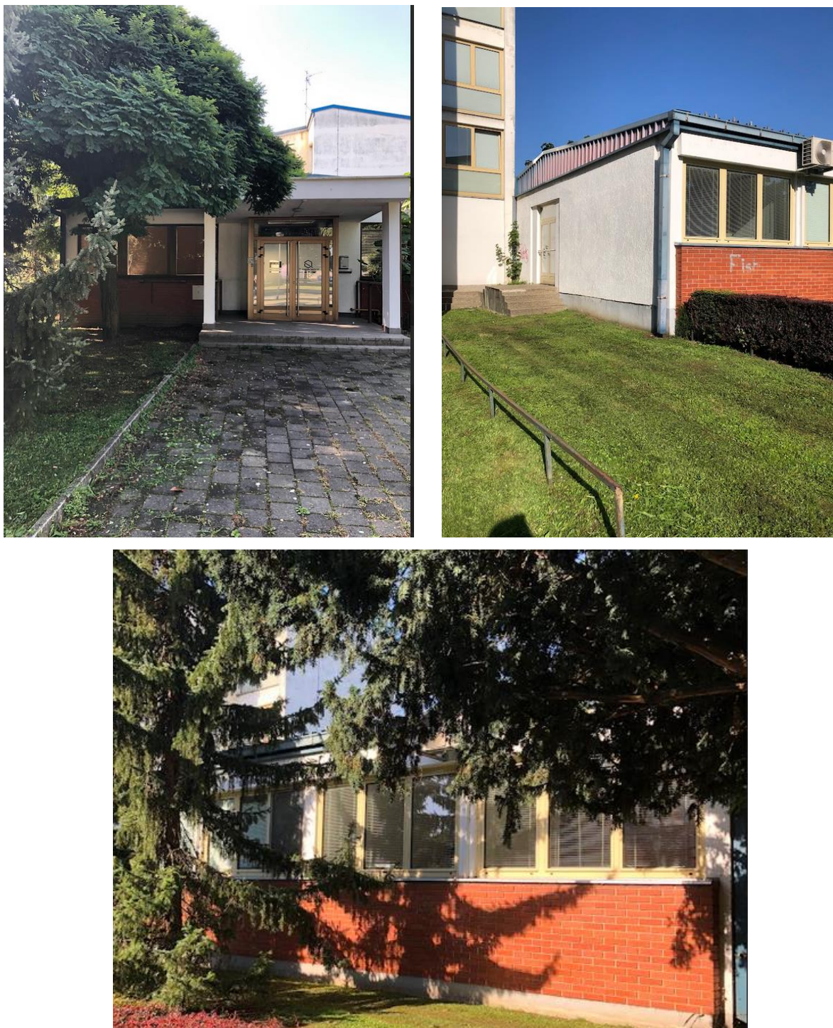
Slika 3. Postojeće stanje pročelja zgrade
