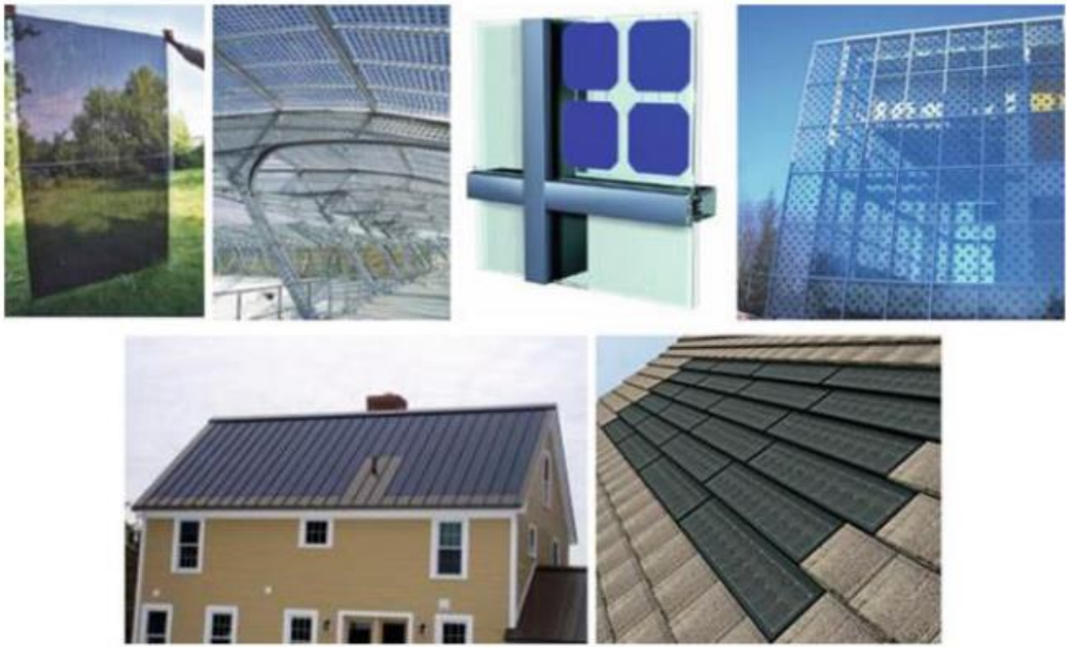
Slika 17. Prikaz različitih rješenja integracije FN modula [25]
