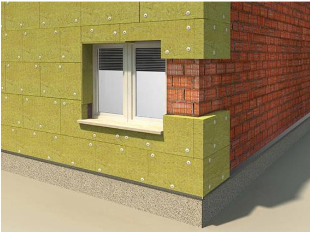
Slika 8. Izolacija vanjskih zidova mineralnom vunom [10]
