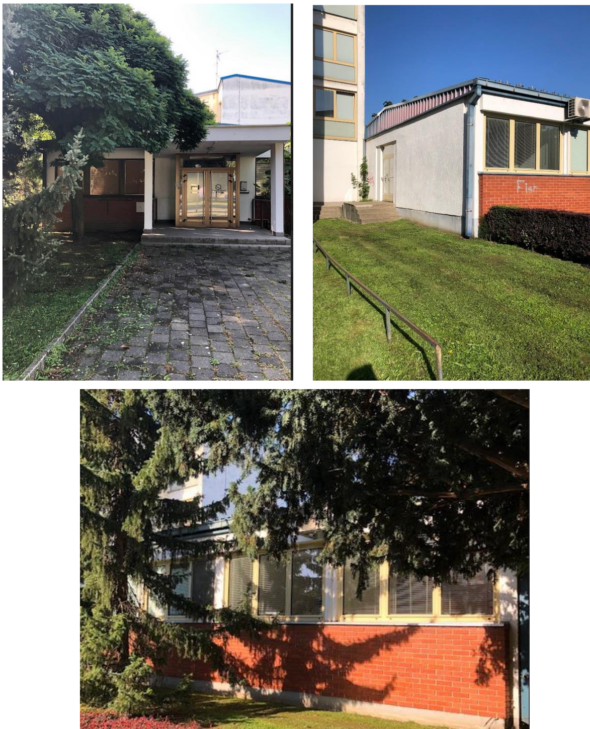
Slika 3. Postojeće stanje pročelja zgrade
