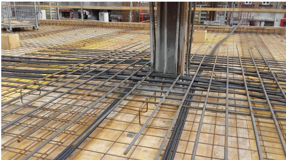
Slika 2.12 Grupiranje kabela koji sudjeluju u smanjenju probojne sile (Izvor: [9])
