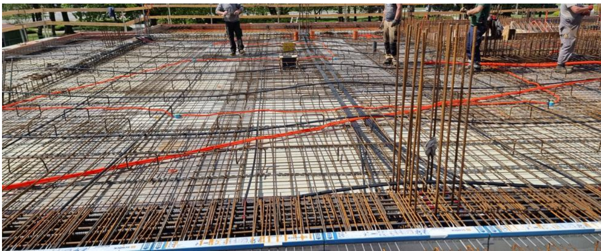
Slika 2.4 Prikaz „unbonded“ kabela za naknadno prednapinjanje (Izvor: [4])
