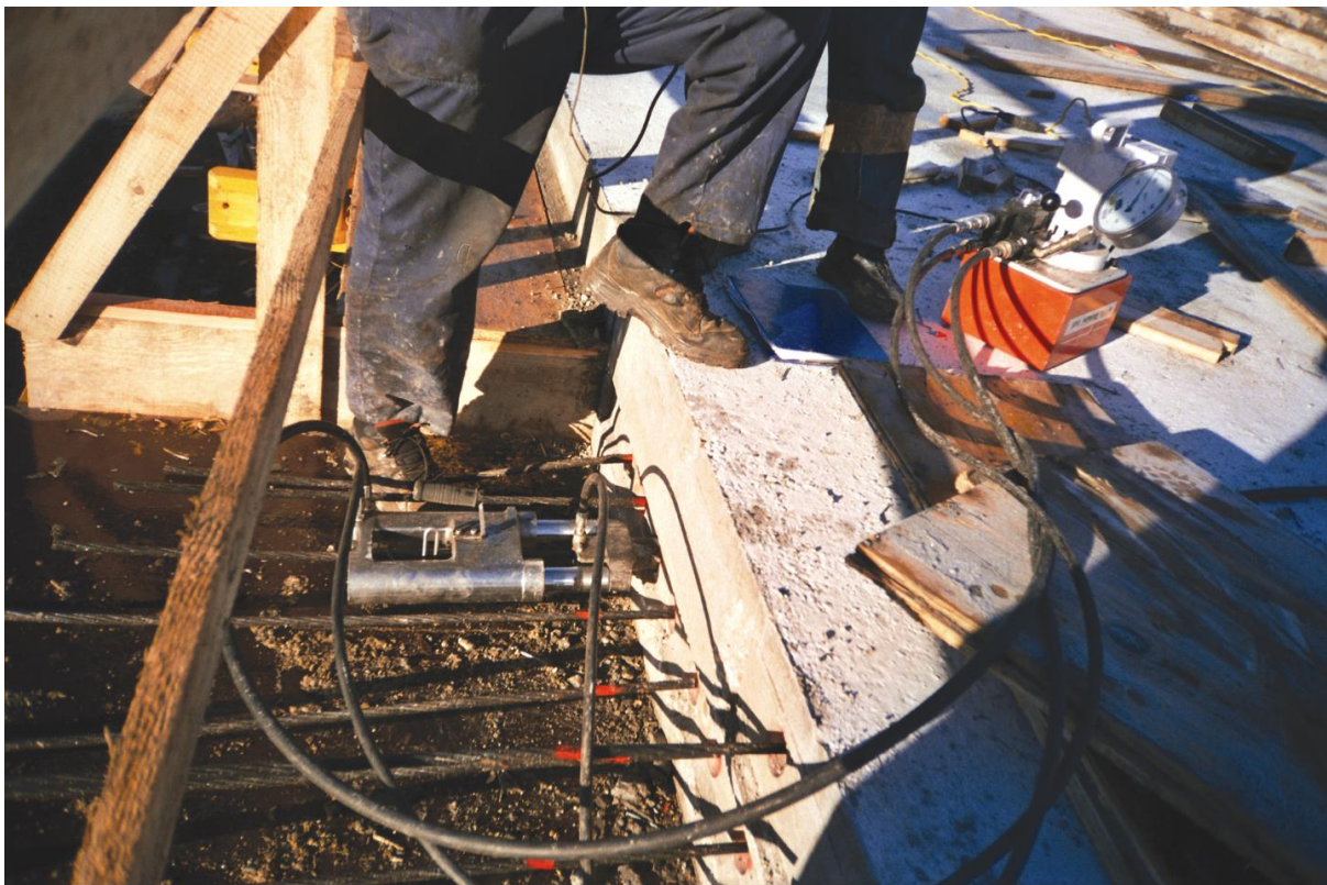
Slika 2.2 Hidraulična preša (crvena markacija pokazuje duljinu izduženja kabela) (Izvor: [5])
