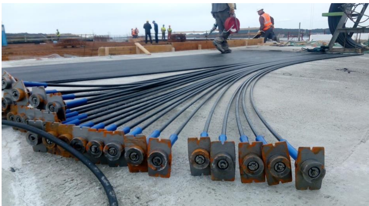
Slika 2.6 Rezanje kabela i montiranje pasivnih usidrenja (Izvor: [3])
