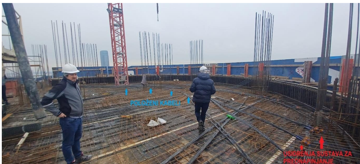
Slika 3.10 Dio 3. faze ciklusa – postavljanje kabela i usidrenja sustava za prednapinjanje
