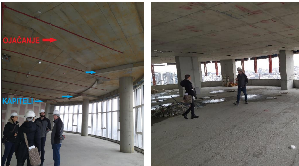
Slika 3.4 Neboder C (lijevo) klasična ploča s kapitelima, neboder B (desno) PT ploča konstantne debljine bez kapitela [Izvor: djelo autora]
