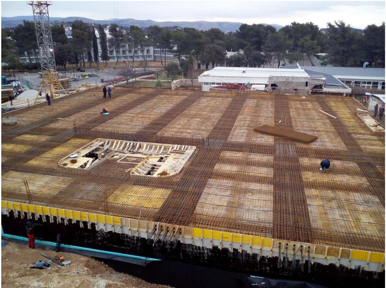
Slika 2.7 Aktivna usidrenja – primjer na izgradnji dvorane u sklopu hotela Solaris u Šibeniku (Izvor: [4])
