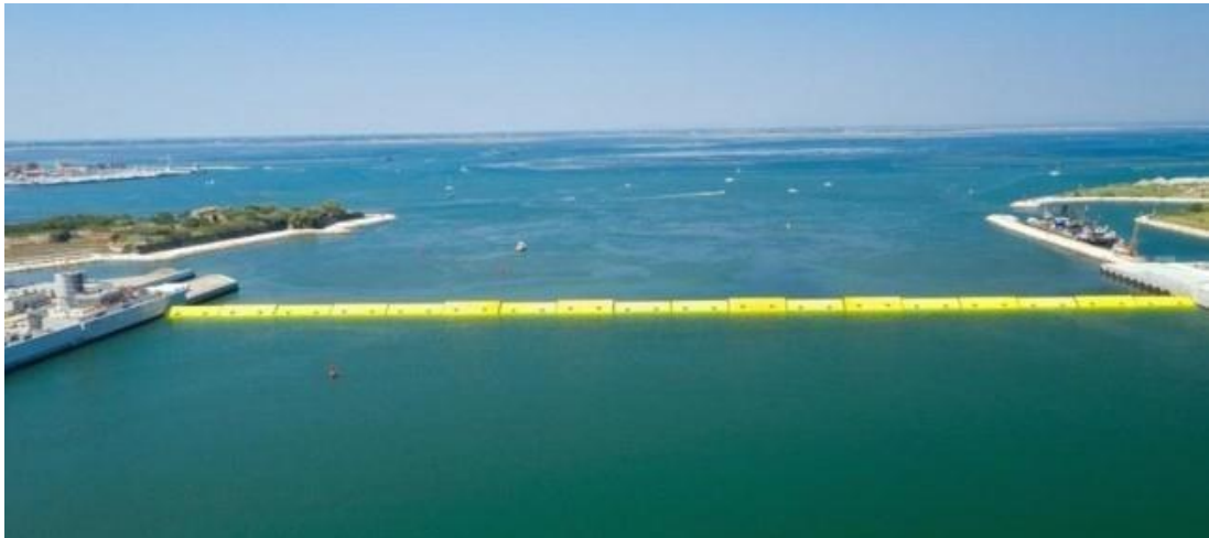
Slika 23: Mobilne barijere sustava MOSE [19]
