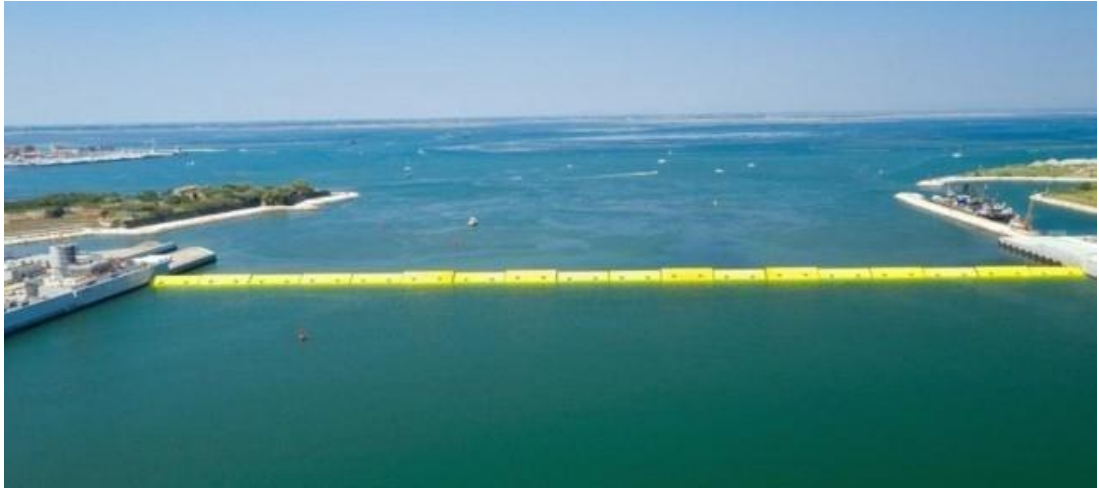
Slika 23: Mobilne barijere sustava MOSE [19]
