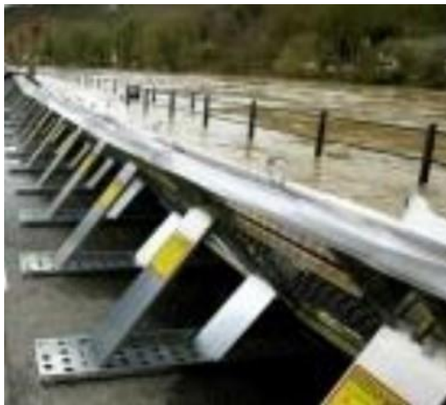
Slika 10: Geodesign pregrada postavljena radi usmjeravanja nabujalih voda [13]
