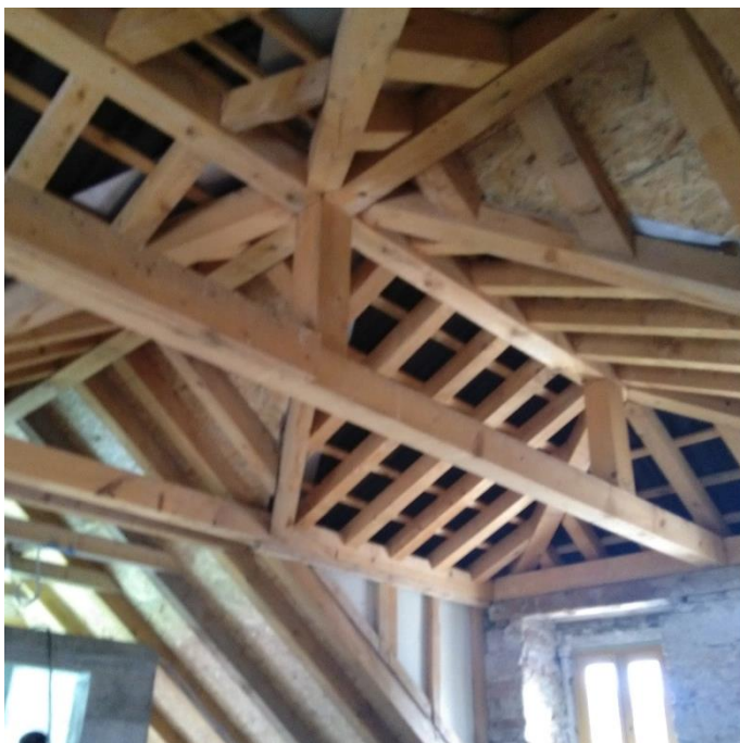
Slika 77. Prikaz sanacije kompleksnog krovišta
