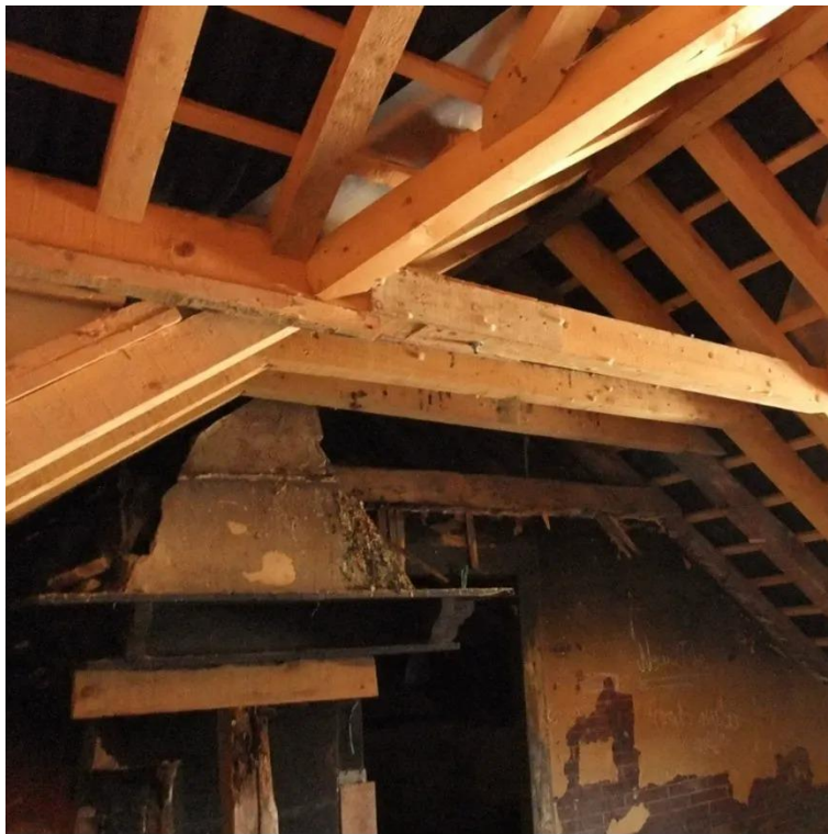
Slika 14. Prethodno obnovljeno krovište
