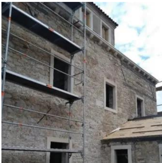
Slika 81. Ojačanje horizontalnim serklažima na rubovima
