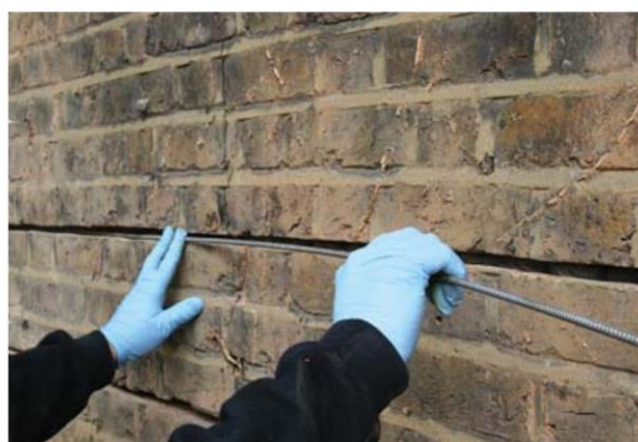
Slika 66. Postava čeličnih šipki u nove fuge
