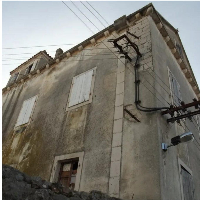
Slika 3. Pročelje sjever i zapad
