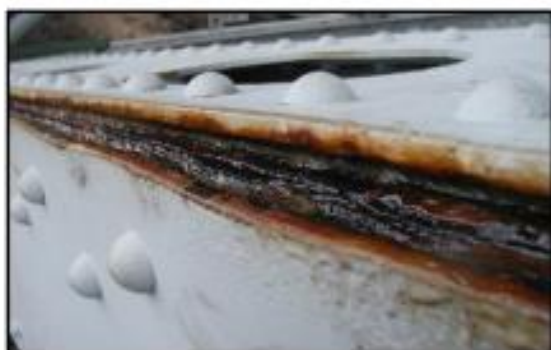
Slika 5.1.2.2 Primjer oštećenja uzrokovana korozijom u procjepu [30]
