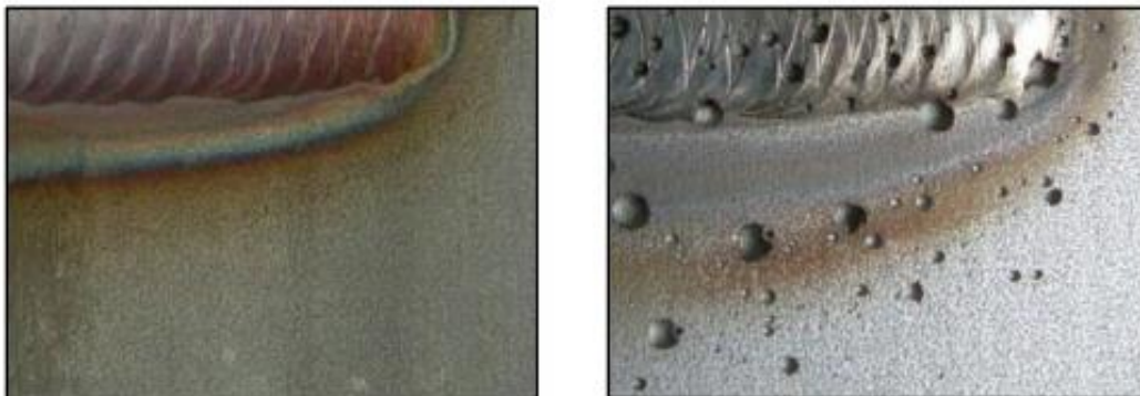
Slika 5.1.1.3 Rupičasta korozija- zone toplinskih nijansi i korozijska oštećenja [30]
