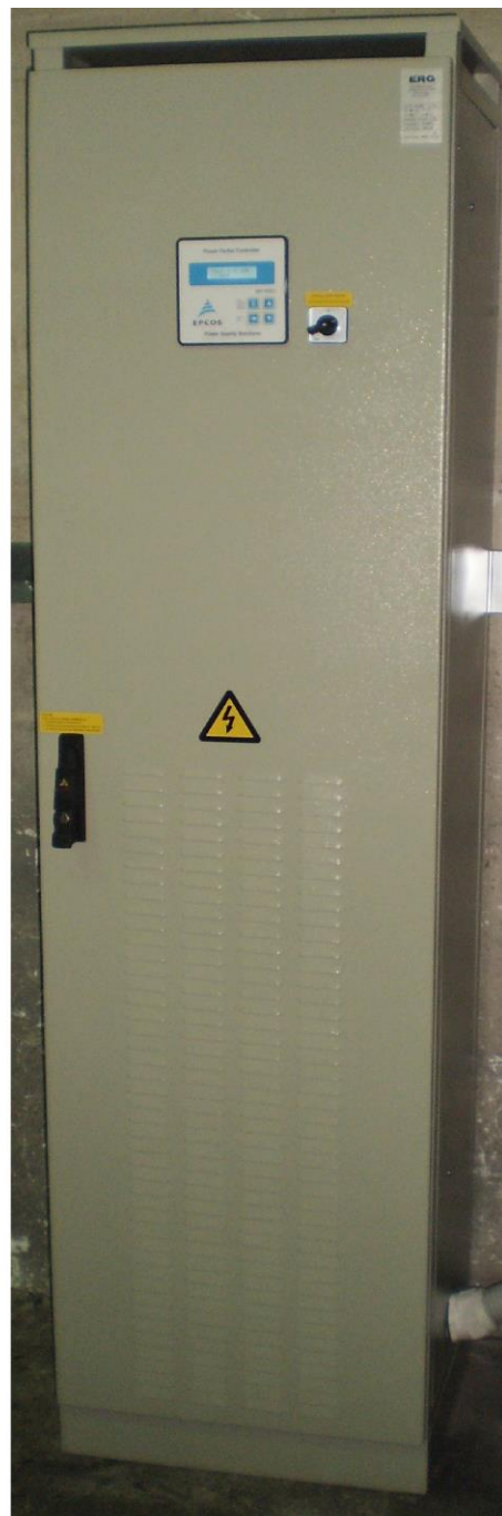
Slika 4.14 Automatski prigušeni kompenzacijski uređaj tip ERG QAPL 090-7
