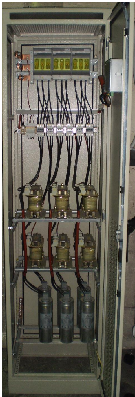
Slika 4.14 Automatski prigušeni kompenzacijski uređaj tip ERG QAPL 090-7
