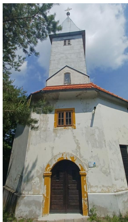
Slika 29: Sjeverno (lijevo) i zapadno (desno) pročelje
