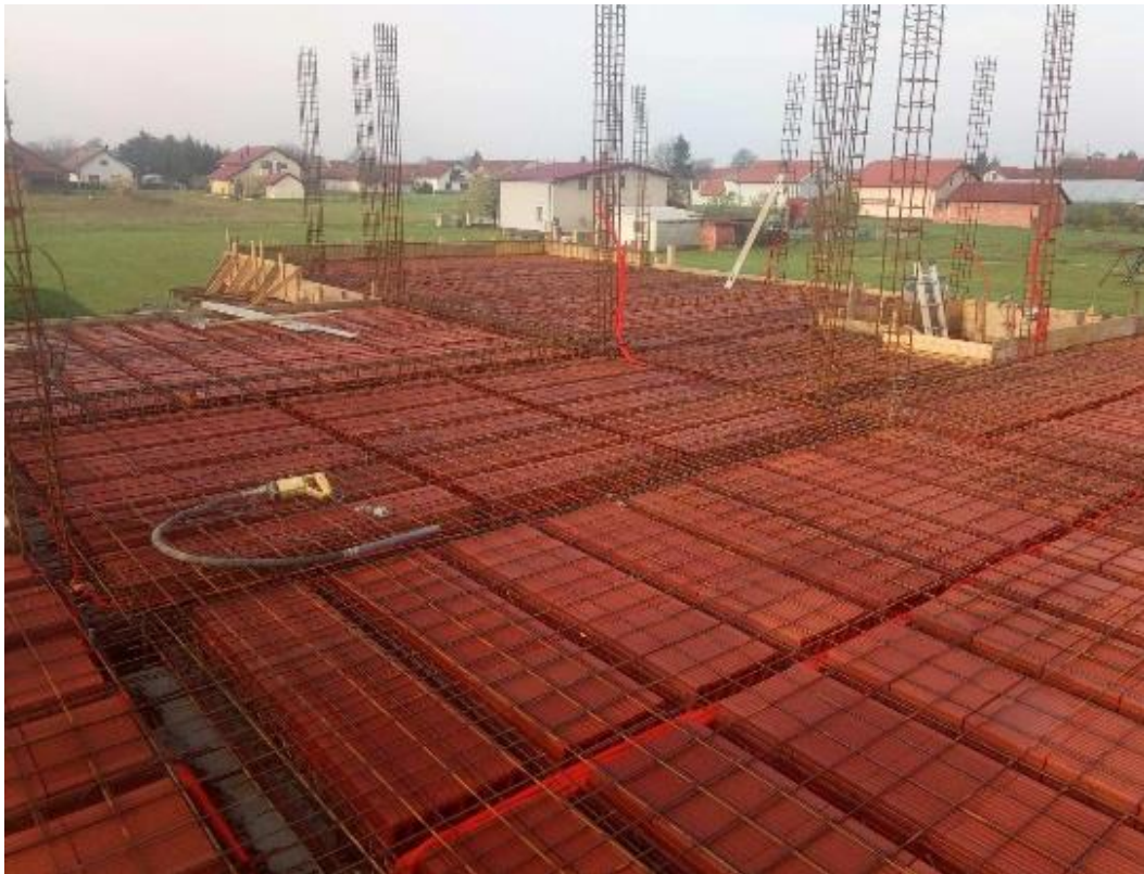
Slika 3.4.3. Postavljena armaturna mreža
