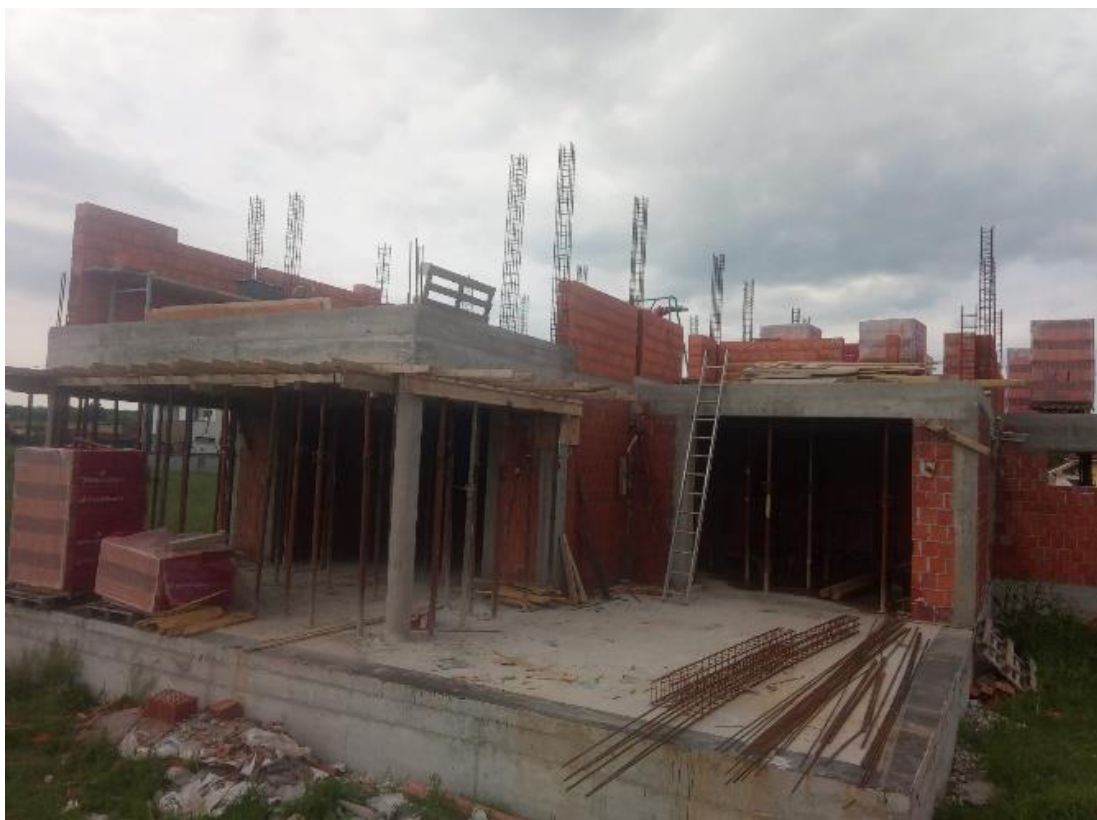
Slika 3.3.2. Betoniranje nadvoja i greda
