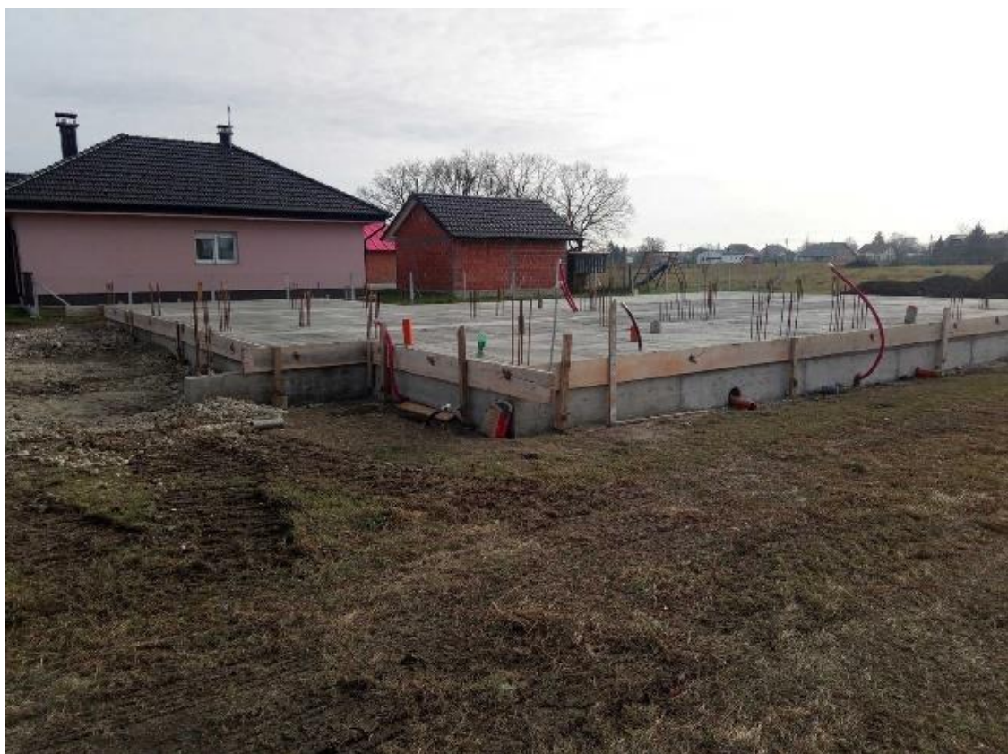
Slika 3.3.1 Betoniranje nadtemeljnih serklaža i AB podne ploče
