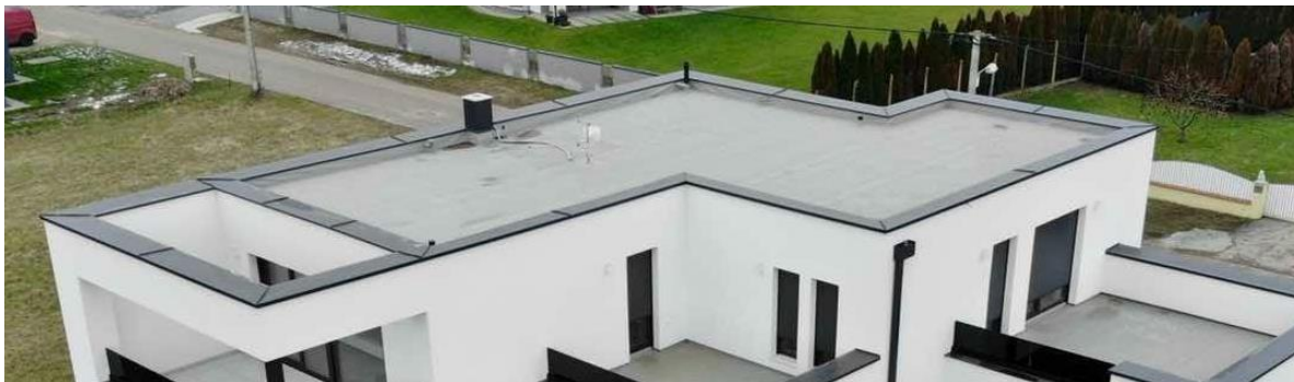
Slika 3.5.1. Izgled TPO folije na krovu
