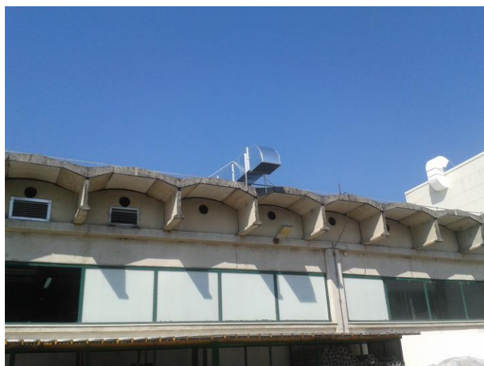
Slika 7.5 Apsorpcijski prigušivač zvuka
