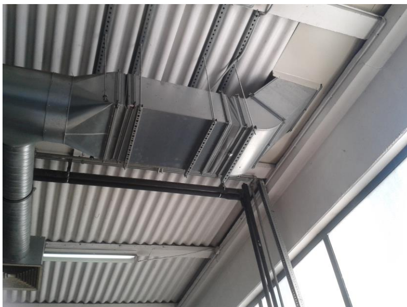
Slika 7.5 Apsorpcijski prigušivač zvuka
