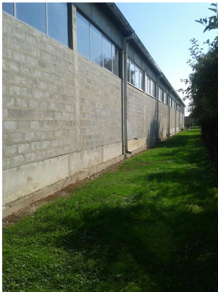
Južna fasada skladišnog objekta
