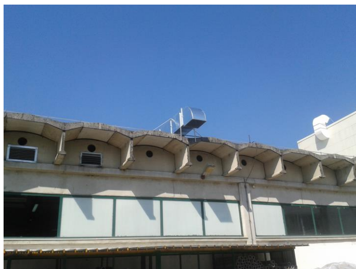
Slika 7.5 Apsorpcijski prigušivač zvuka
