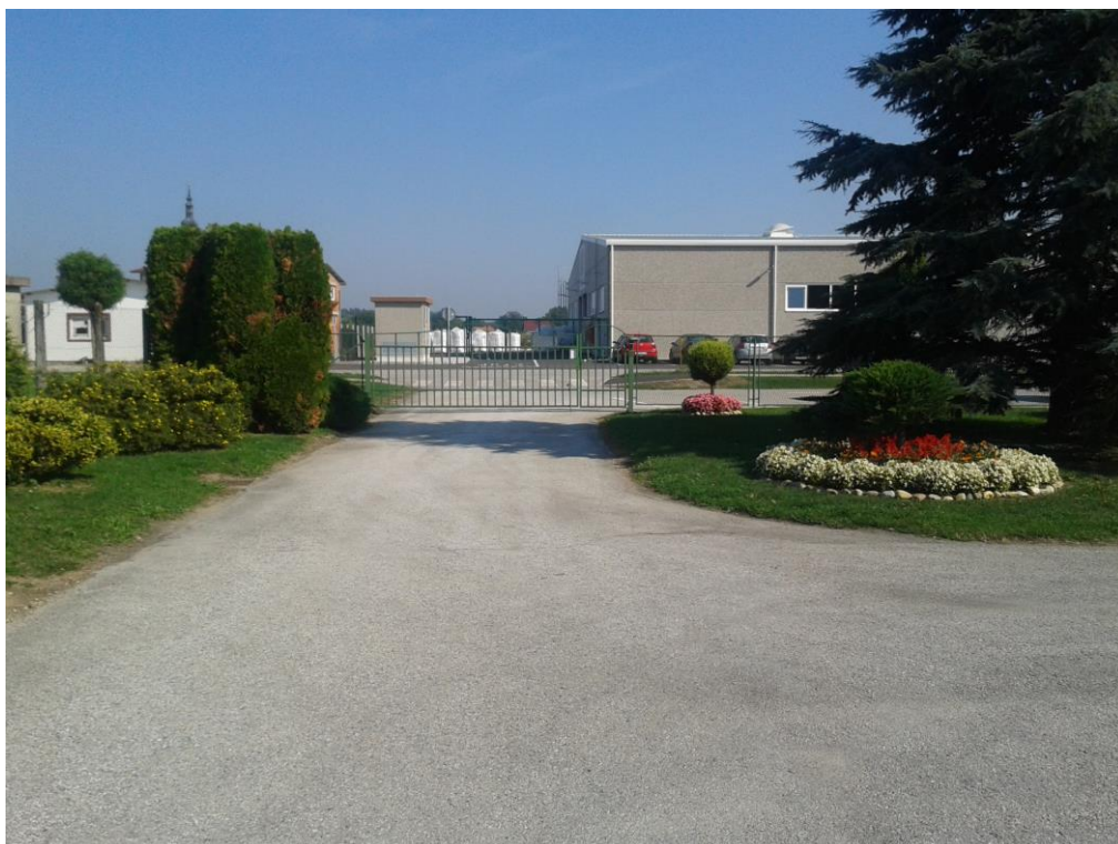
Sjeverozapadni ugao parcele (Mjerno mjesto 2 - prilikom mjerenja vanjske buke)
