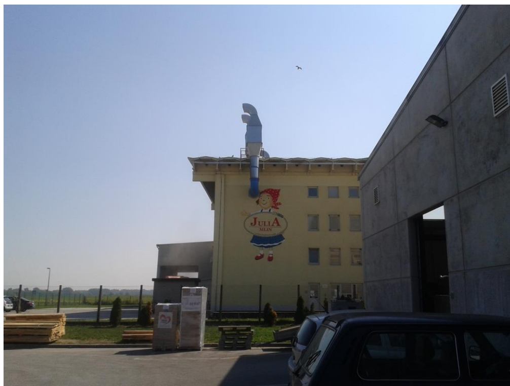
Sjeveroistočni ugao parcele (Pogled na prostore mlina JULIA)
