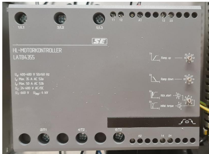
Slika 2.4 – Soft-starter na dvije faze, model LATB4355[2]
