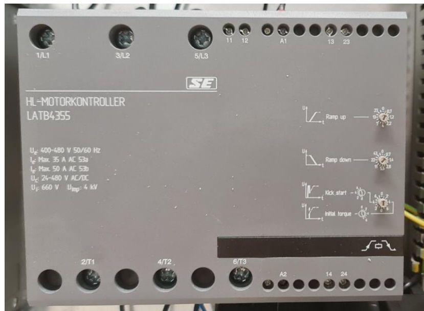
Slika 2.4 – Soft-starter na dvije faze, model LATB4355[2]
