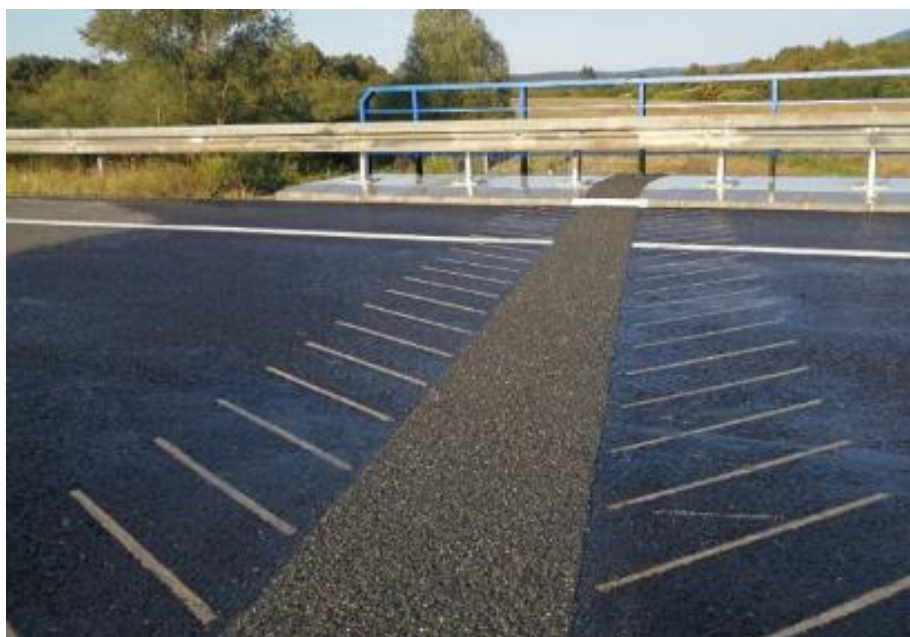
Slika 18 Bitumenska kontinuirana prijelazna naprava, [4]
