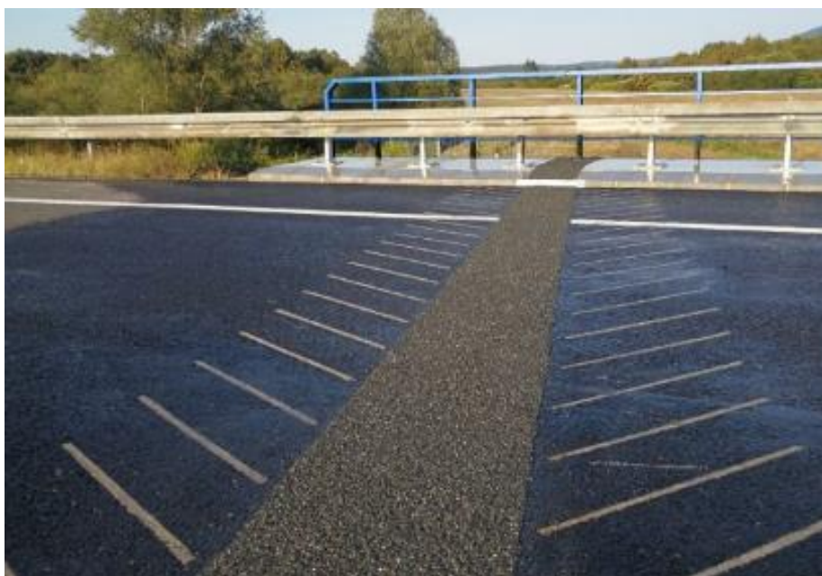
Slika 18 Bitumenska kontinuirana prijelazna naprava, [4]
