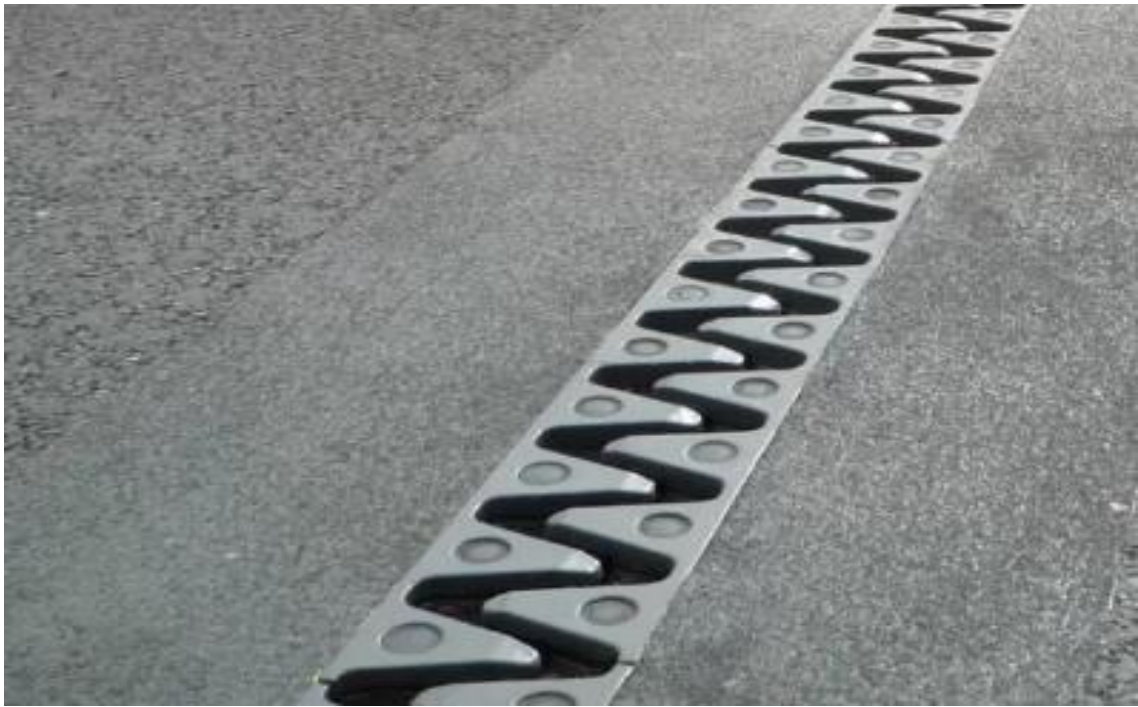
Slika 23 Jednoprofilna prijelazna naprava sa polimer betonom, [4]
