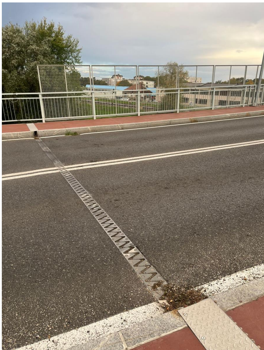
Slika 31 Jednoprofilna prijelazna naprava na nadvožnjaku u Čakovcu, (10.10.2024.)
