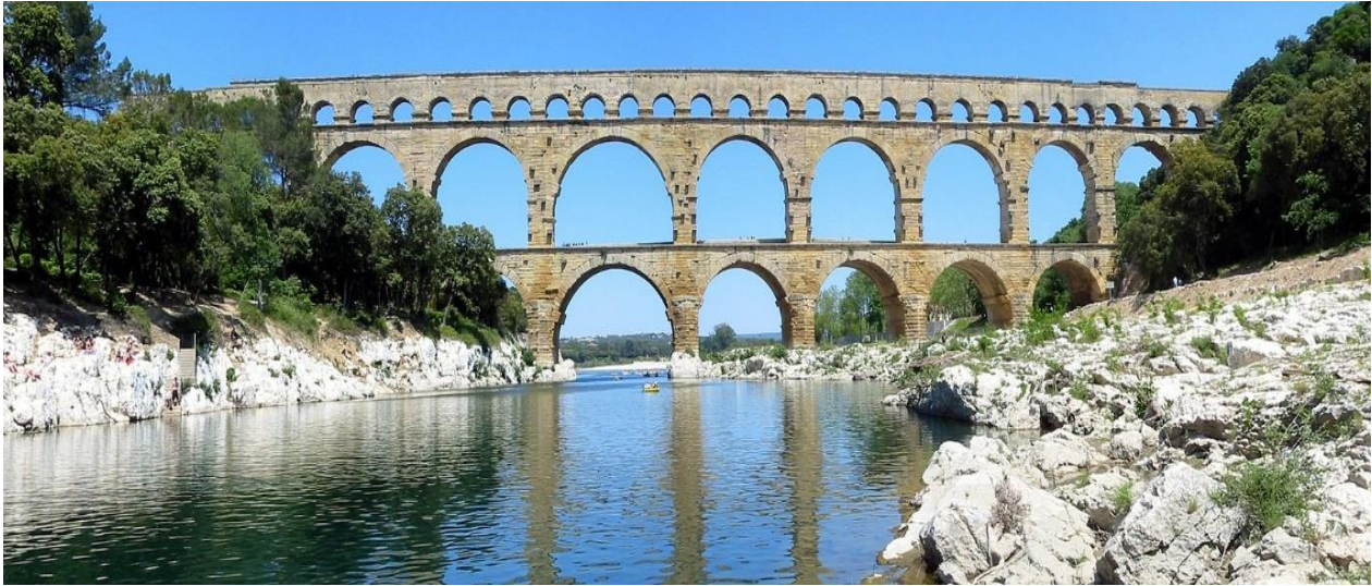
Slika 2. Most Pont du Gard [3]
