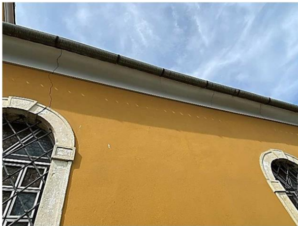
Slika 35. Vertikalna pukotina sjevernog pročelja
