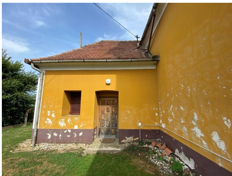
Slika 12. Prikaz zapadnog pročelja
