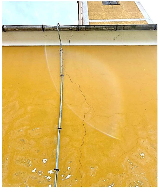
Slika 35. Vertikalna pukotina sjevernog pročelja
