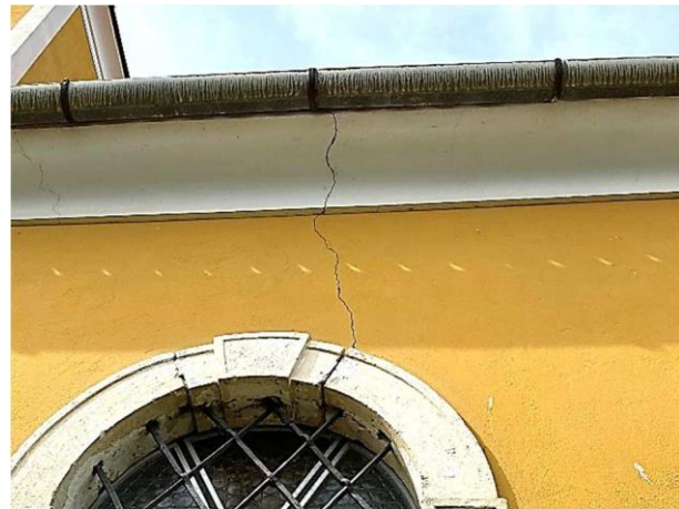
Slika 35. Vertikalna pukotina sjevernog pročelja
