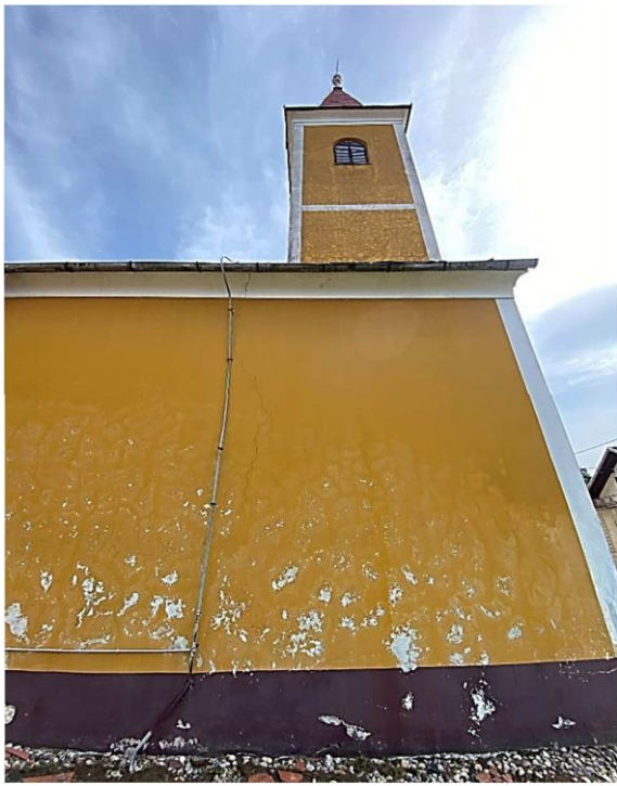
Slika 35. Vertikalna pukotina sjevernog pročelja
