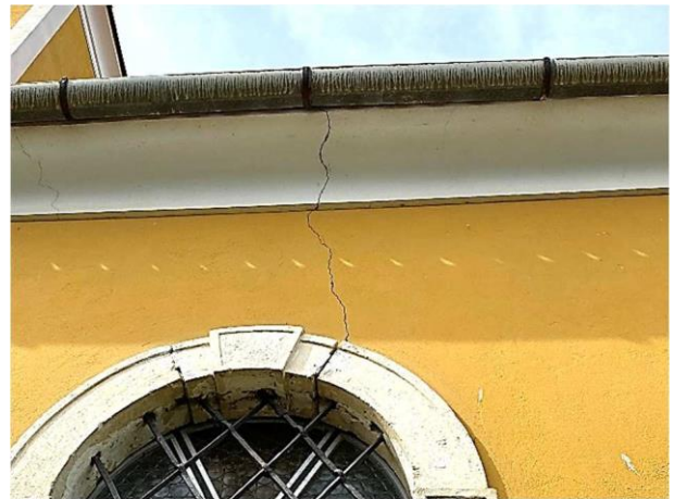
Slika 35. Vertikalna pukotina sjevernog pročelja
