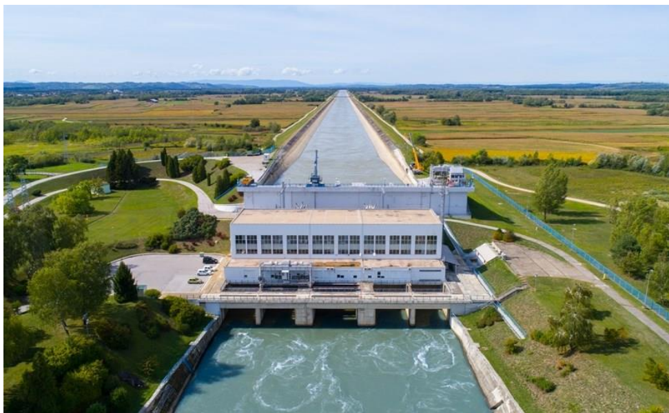
Slika 2.2 Zgrada strojarnice HE Varaždin izvana
