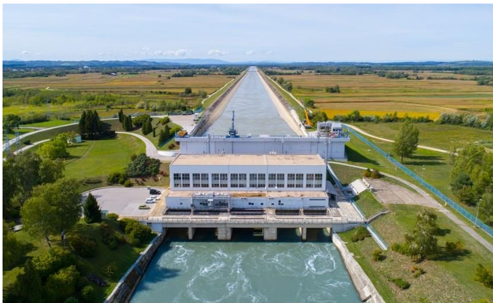
Slika 2.2 Zgrada strojarnice HE Varaždin izvana
