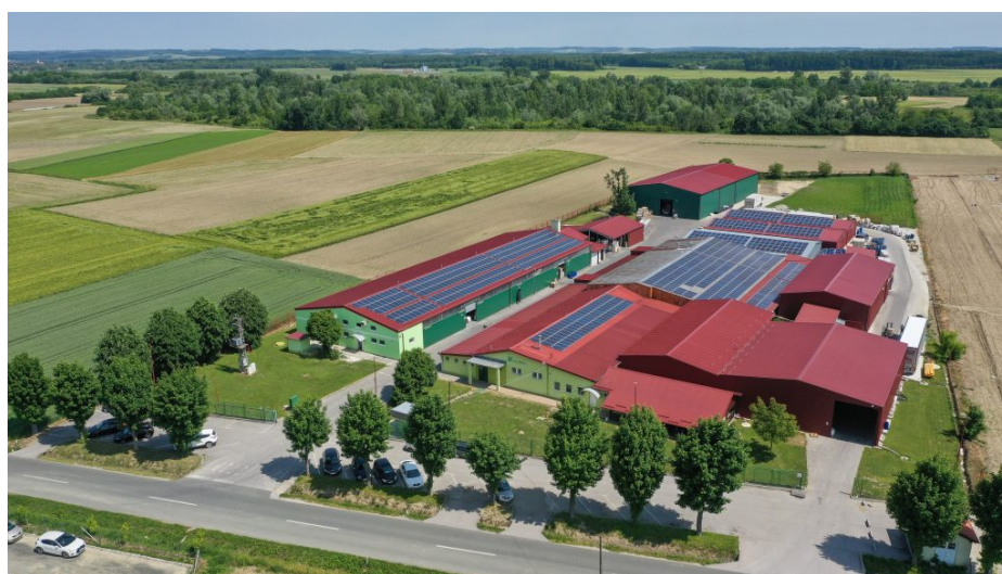
Slika 4 Tvrtka Eko papir prije druge faze postavljanja solarnih panela
