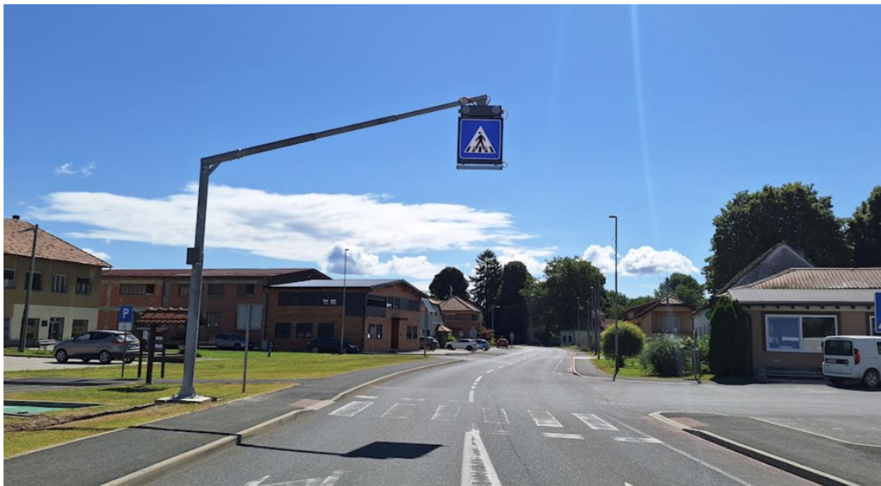
Slika 4. Fotografija sanacije pješačkog prijelaza na ŽC2076 u mjestu Mali Bukovec
