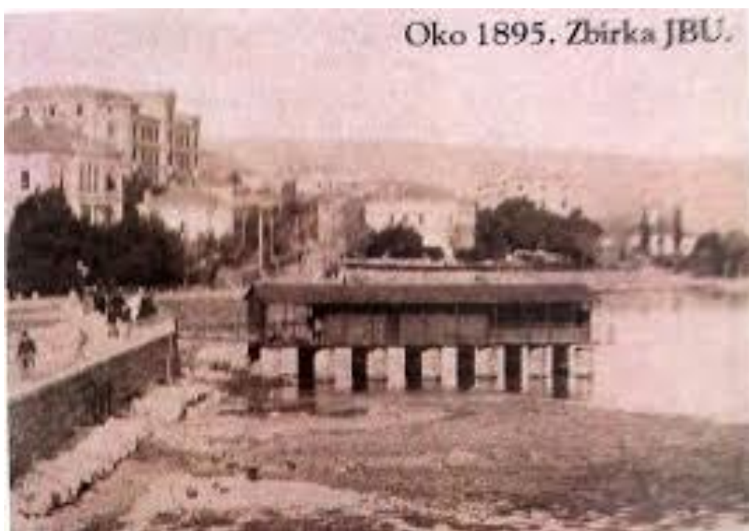
Slika 2.4.1.2. Početci izgradnje kupališta,
