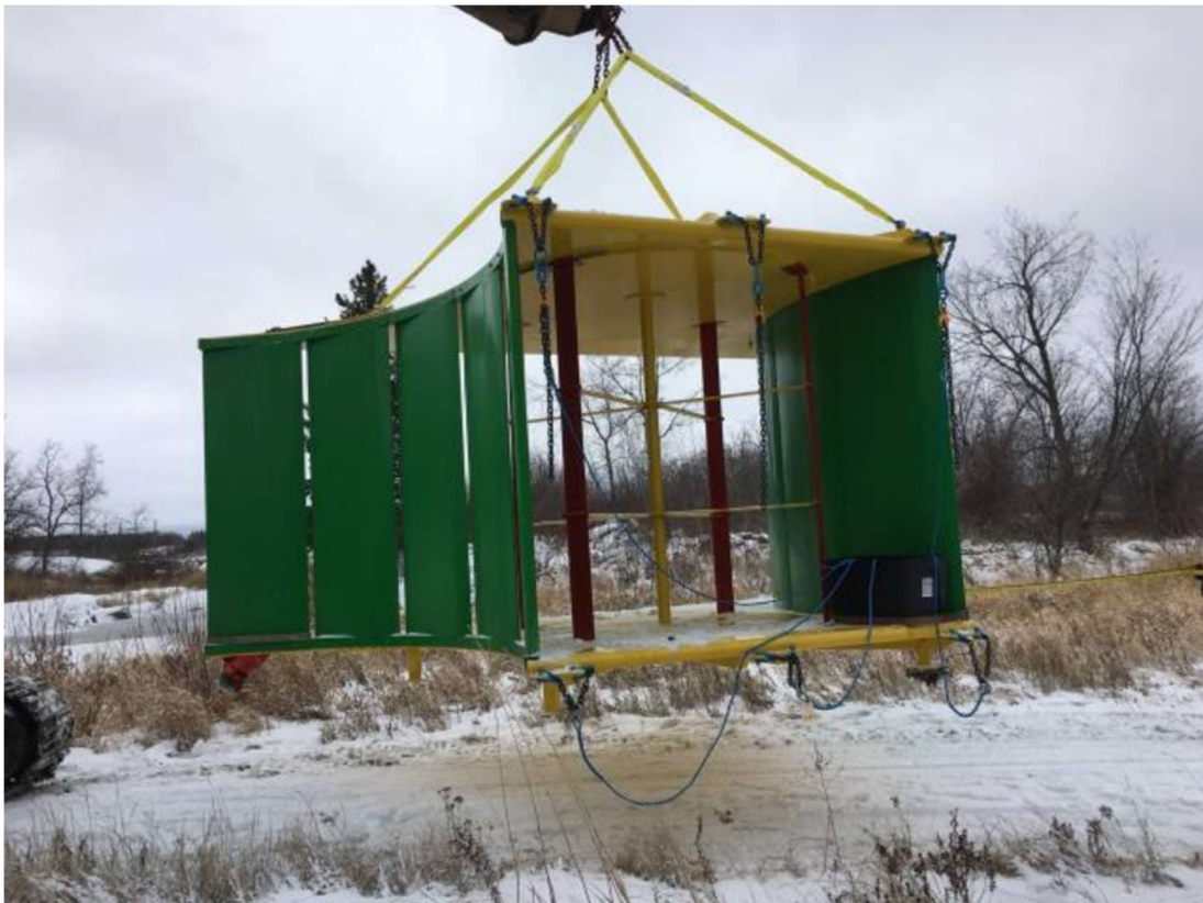
Slika 2.19 Prikaz Venturi turbine prilikom ugradnje [11]
