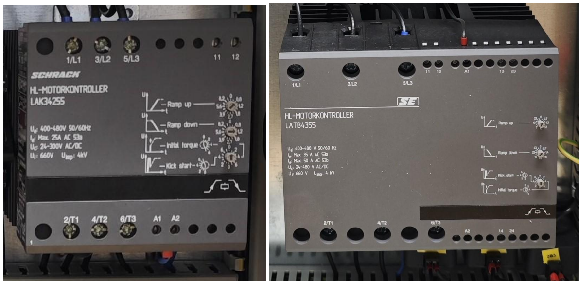
Slika 2.6 Soft starteri sa upravljanjem u: a) dvije fazi b) tri faze
