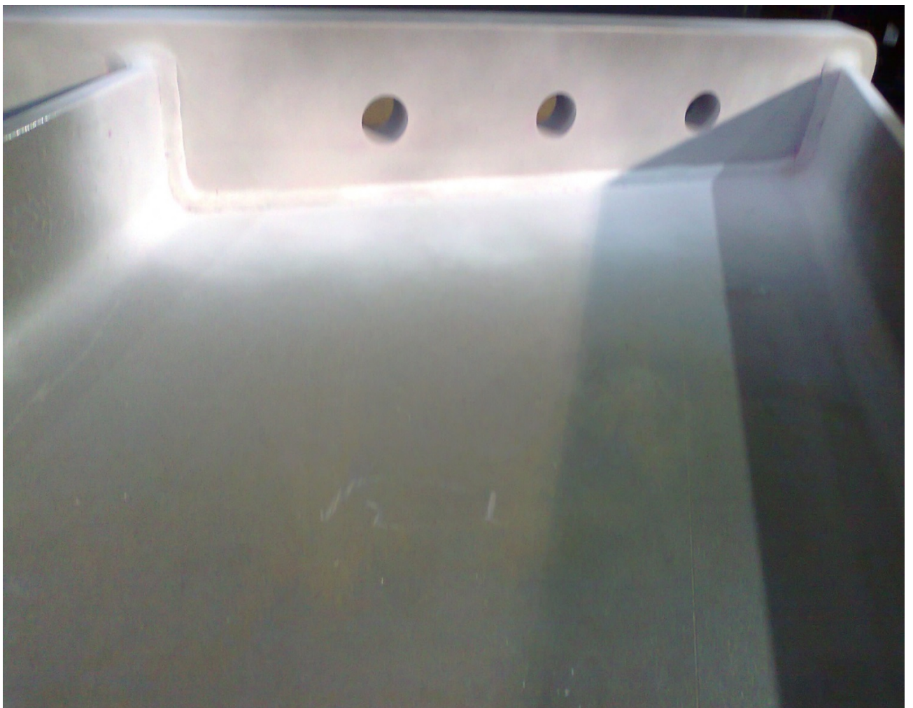
Slika 9. 27 Završna slika penetrantske kontrole zavara
