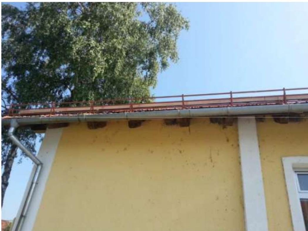
SLIKA 4.3. Postavljen snjegobran na predmetnoj solarnoj elektrani
