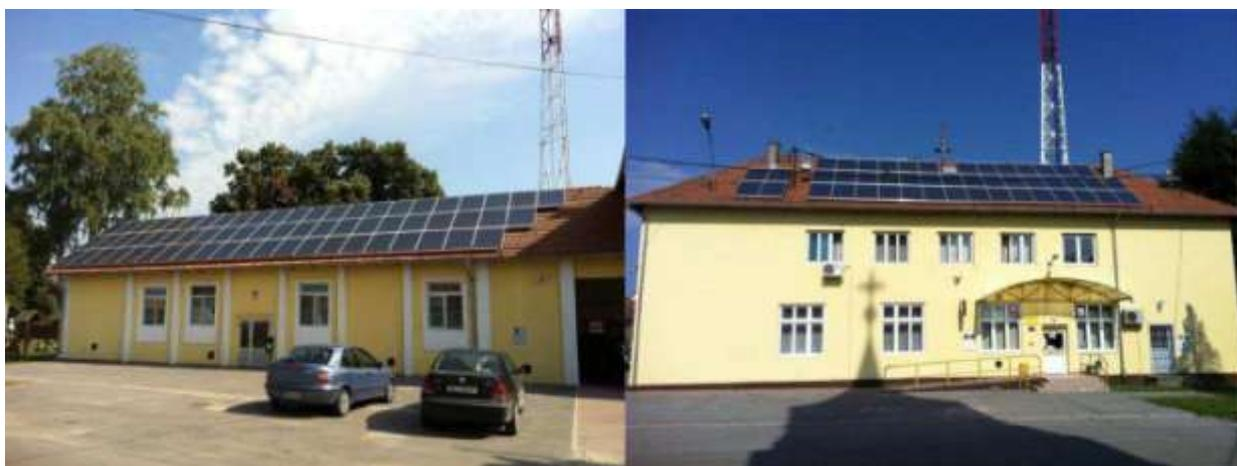
SLIKA 4.1. Prikaz predmetne solarne elektrane (desna strana - južni krov, lijeva strana - istočni krov)
