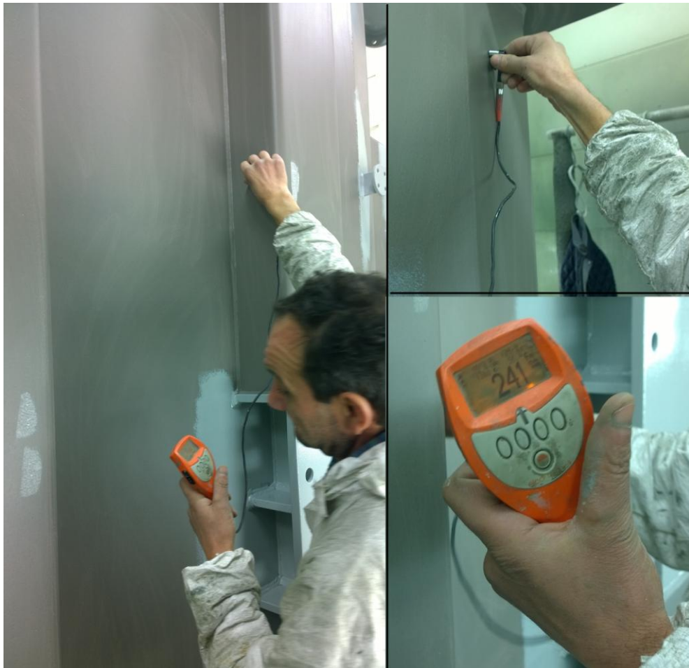
Slika 6.19 Kontrola debljine prethodno nanesenih sloja prije lakiranja
