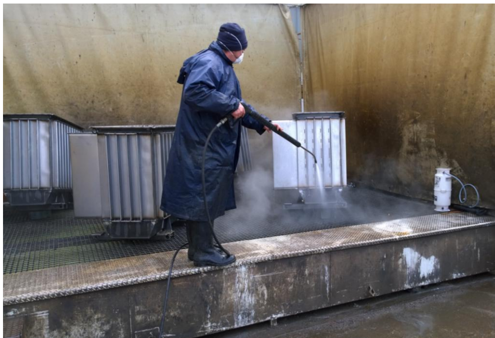
Slika 5.4 Odmašćivanje visokotlačnim prskanjem
