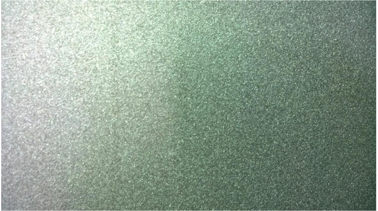
Slika 6.4 Izgled površine nakon sačmarenja, stupanj Sa 2,5
