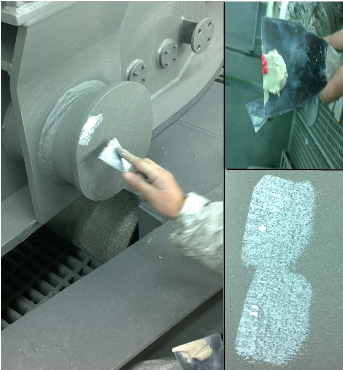
Slika 6.18 Popravljanje grešaka kitom
