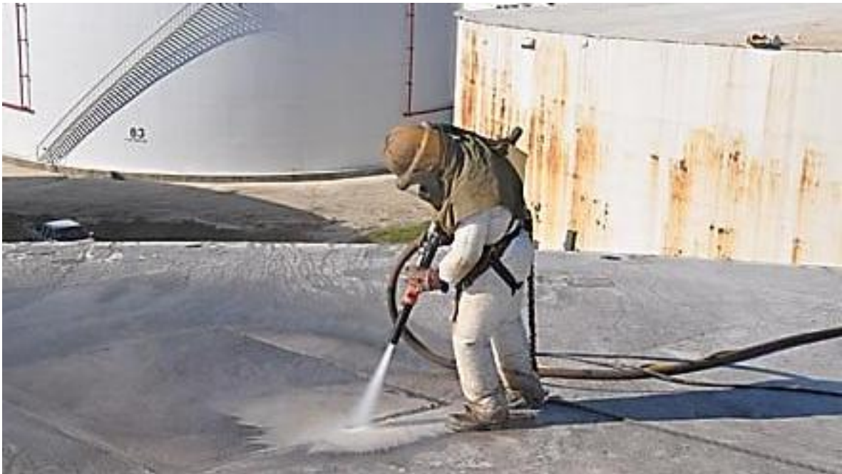
Slika 5.6 Postupak pjeskarenja [43]
