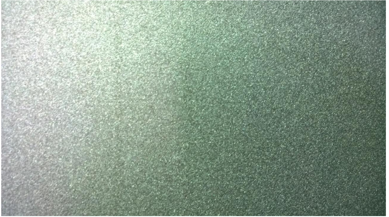
Slika 6.4 Izgled površine nakon sačmarenja, stupanj Sa 2,5
