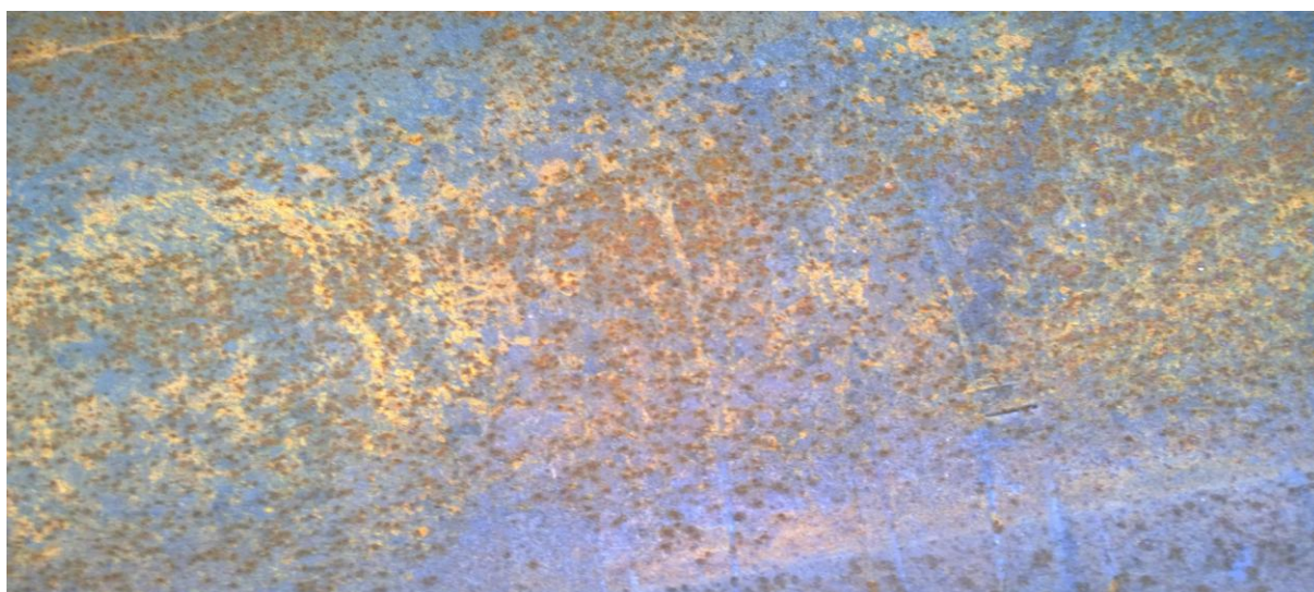
Slika 6.1 Izgled površine prije sačmarenja
