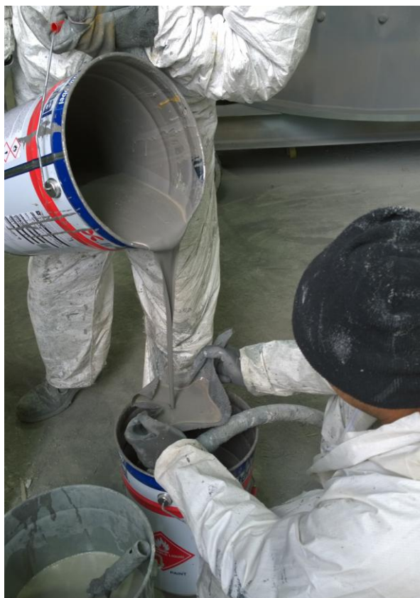
Slika 6.8 Prelijevanje boje preko sita
