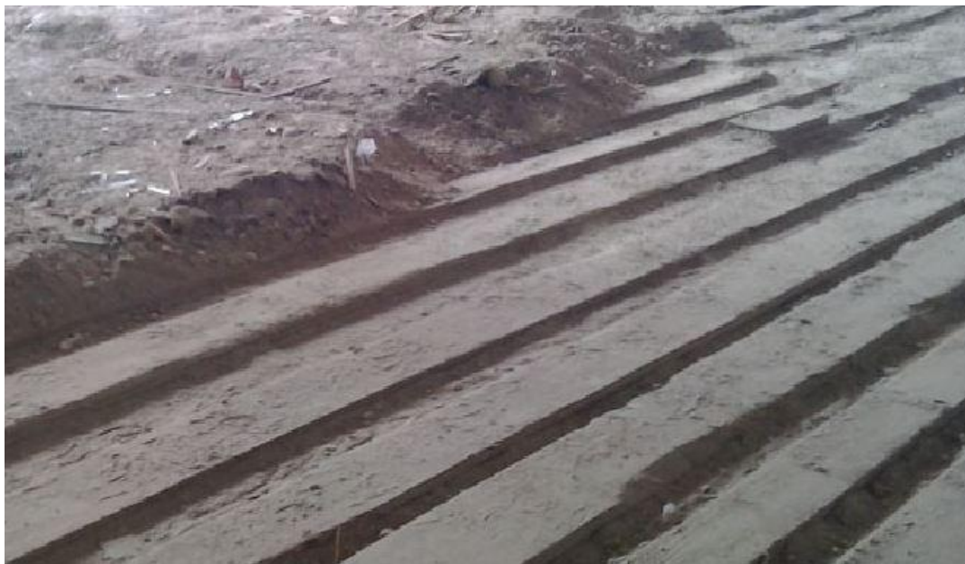
Slika 16 Postojeće stanje slojeva stropa
