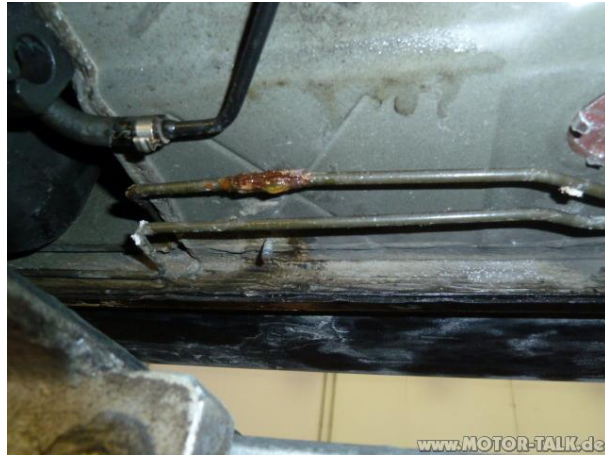
Slika 5.2.1 Korodirana kočiona cijev
