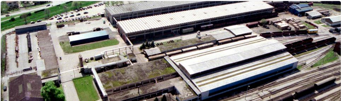
Slika 24. Radionica željezničkih vozila Čakovec d.o.o.
