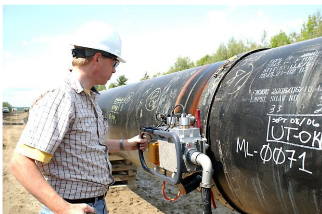
Slika 22. Primjer radiografskog ispitivanja zavarenog spoja na cijevi
