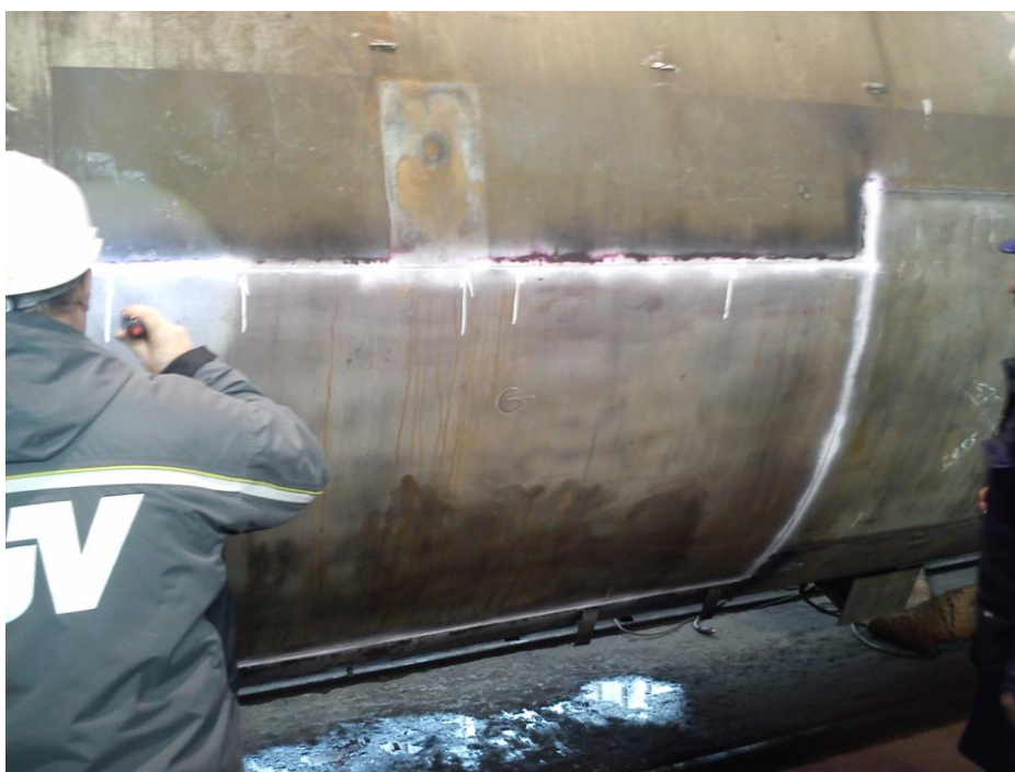
Slika 32. Pregled zavarenih spojeva nakon ispitivanja
