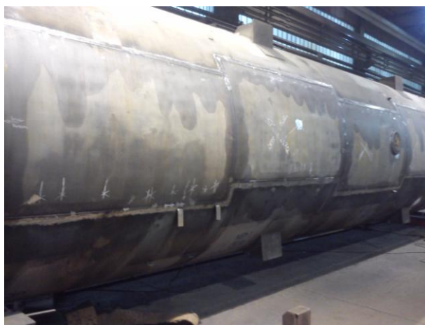
Slika 28. Očišćene površine zavarenih spojeva
