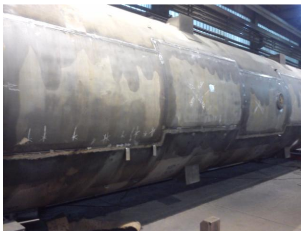
Slika 28. Očišćene površine zavarenih spojeva
