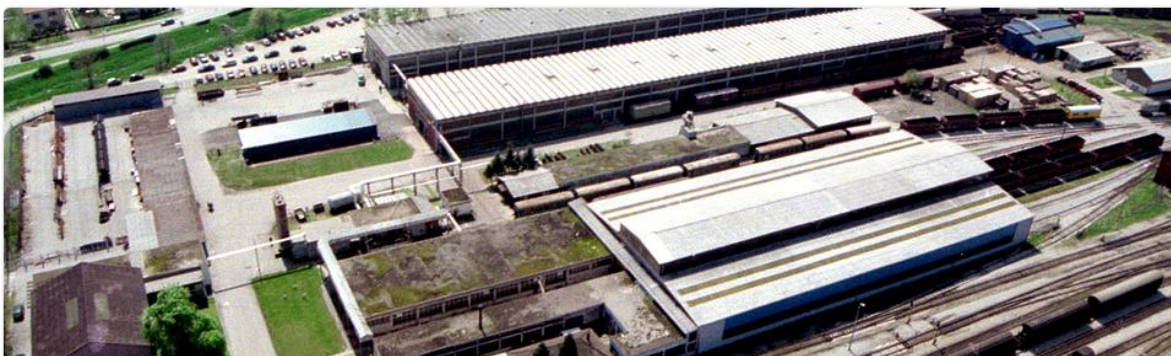
Slika 24. Radionica željezničkih vozila Čakovec d.o.o.
