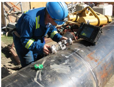
Slika 20. Primjer ultrazvučnog ispitivanja zavarenog spoja na cijevi
