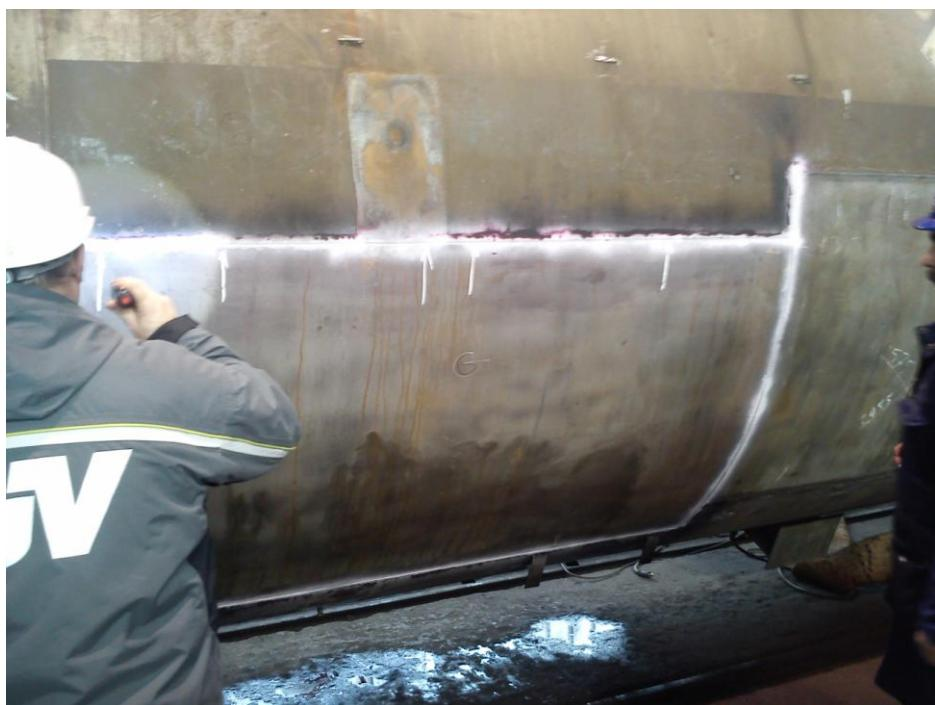
Slika 32. Pregled zavarenih spojeva nakon ispitivanja
