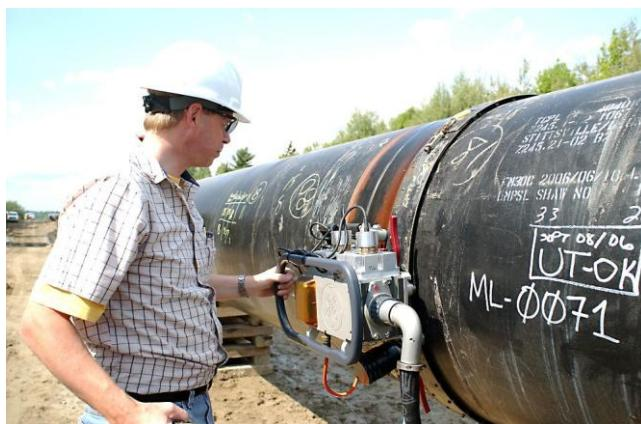
Slika 22. Primjer radiografskog ispitivanja zavarenog spoja na cijevi
