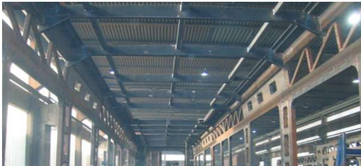
*Slika 6.20 Konstrukcija krova nakon zavarivanja*
