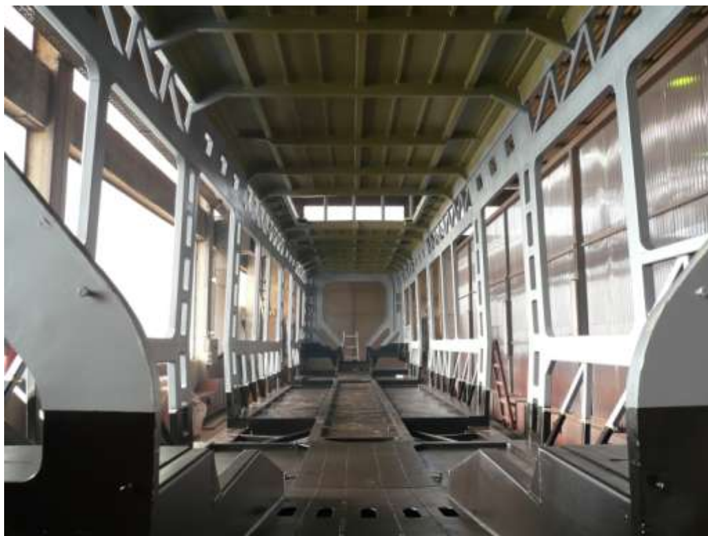
Slika 6.21 Konstrukcija krova nakon primjene AKZ
