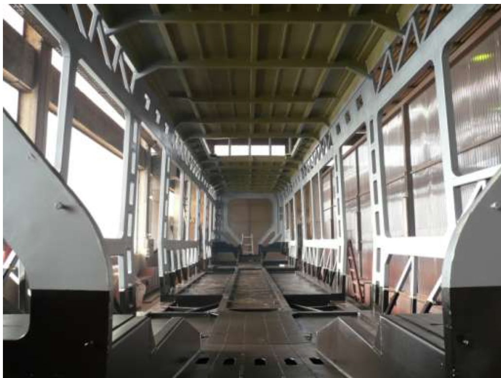
Slika 6.21 Konstrukcija krova nakon primjene AKZ
