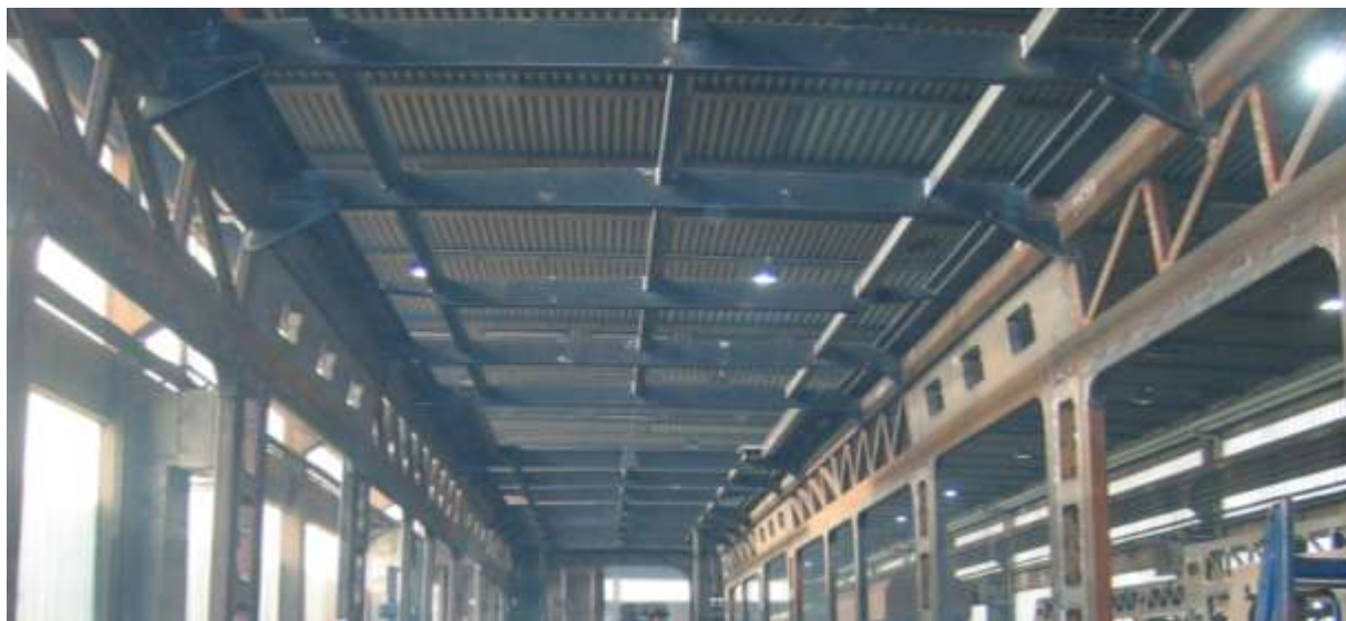
Slika 6.20 Konstrukcija krova nakon zavarivanja
