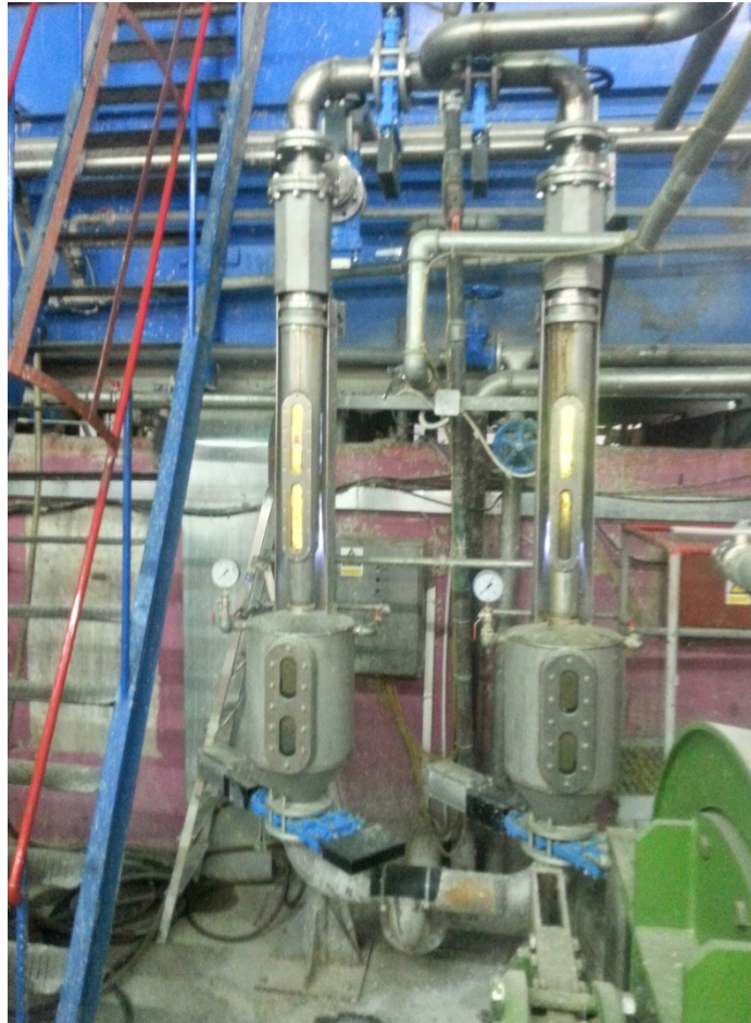
Slika 2.3: Centrifugalni pročišćivači
