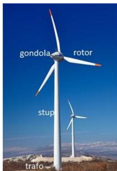
Slika 4 Vjetroagregat sa označenim dijelovima
