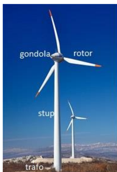
Slika 4 Vjetroagregat sa označenim dijelovima
