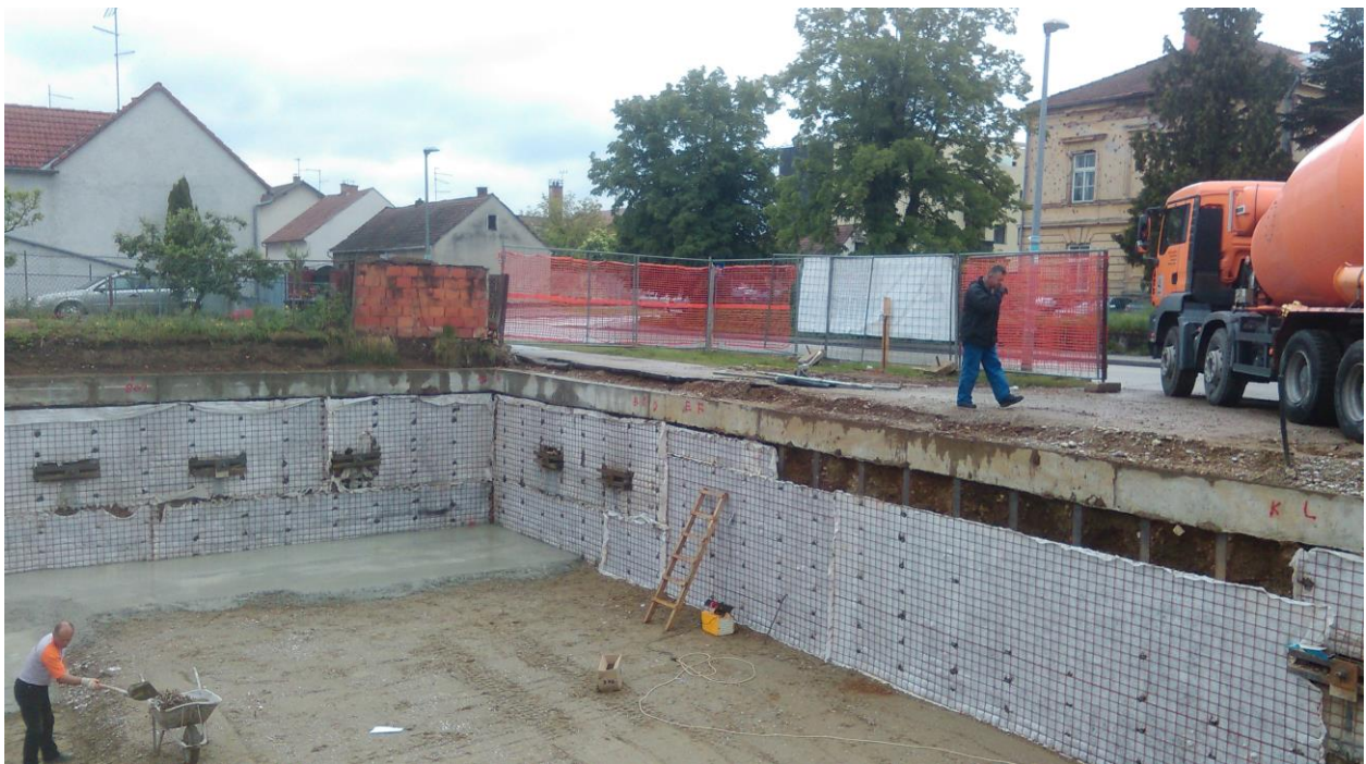
Slika 39. Presvlačenje pilotske stjenke geotekstilom i armaturnom mrežom
