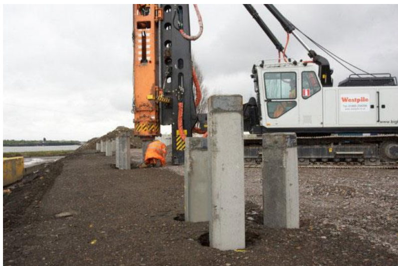
Slika 10. Betonsko žmurje
