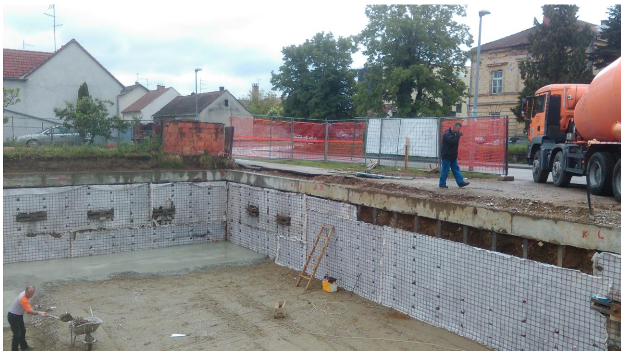
Slika 39. Presvlačenje pilotske stjenke geotekstilom i armaturnom mrežom
