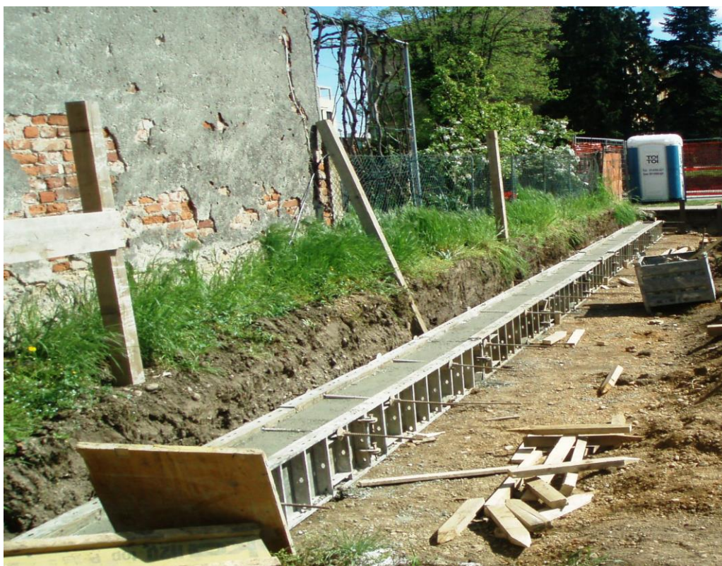
Slika 31. Zabijanje čeličnih IPE profila
